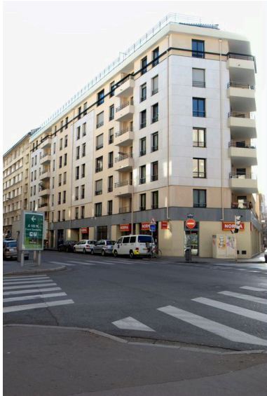
Vue générale Phot. Maryannick Chalabi IVR82_20116901656NUCA
