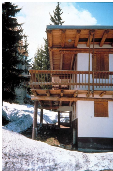
Vue de la coursière Phot. Jean-François Lyon-Caen IVR82_19987300079ZA
