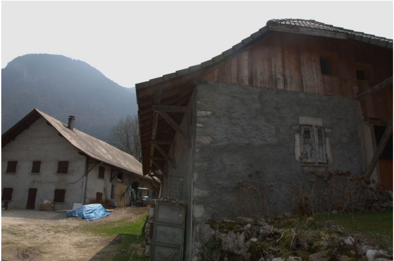
Mur pignon nord du second moulin
