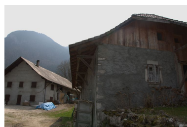
Mur pignon nord du second moulin Phot. Samir Mahfoudi, Autr. Samir Mahfoudi IVR82_20107403198NUCA
