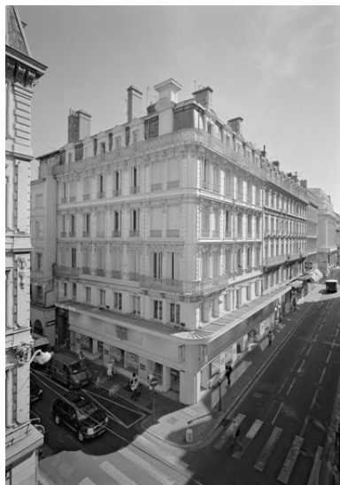
Vue de la portion entre la rue de Brest (au premier plan) et celle du Président-Edouard-Herriot
