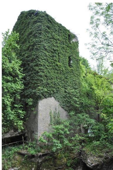
Vue d'un des bâtiments présents sur le site des moulins Dalby Phot. Yannick Milleret IVR82_20127301803NUCA
