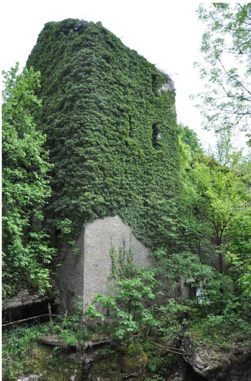
Vue d'un des bâtiments présents sur le site des moulins Dalby
