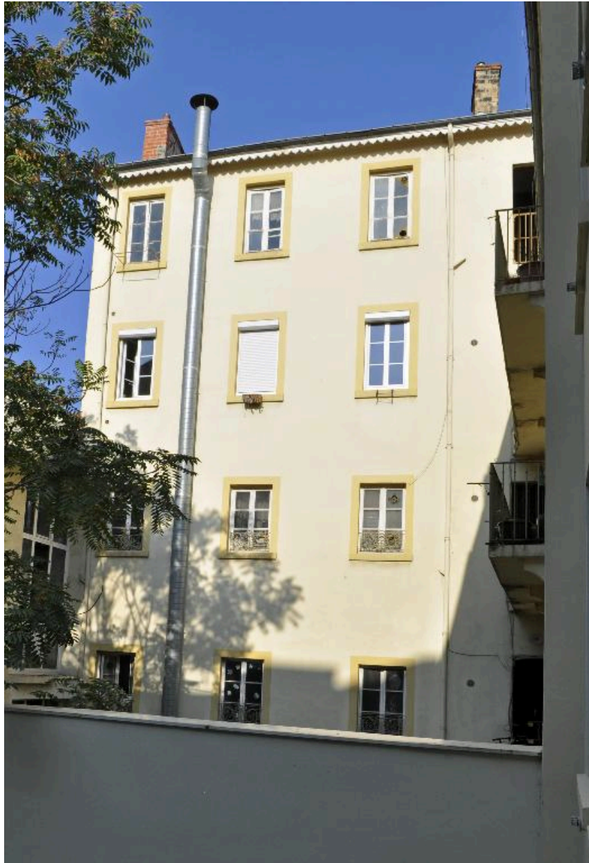
Immeuble sur rue, élévation postérieure
