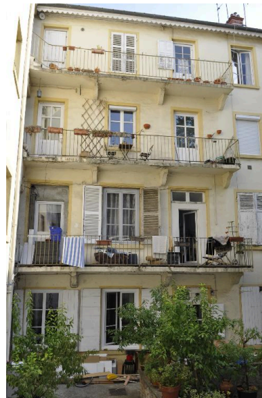
Immeuble sur cour, système de circulation par coursières Phot. Catherine Guégan IVR82_20156902524NUCA
