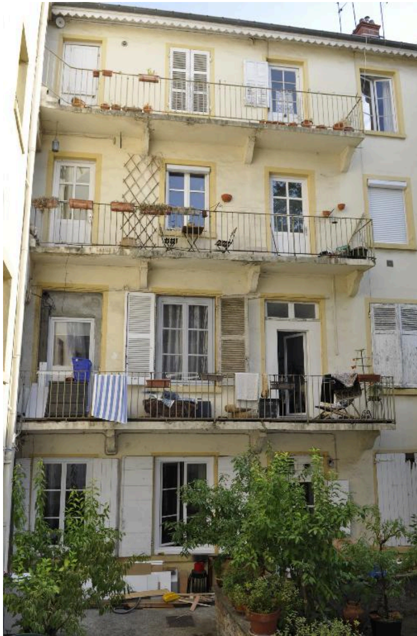
Immeuble sur cour, système de circulation par coursières
