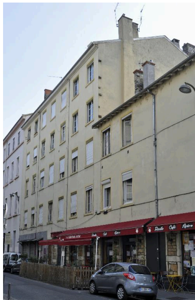
Immeuble sur rue, élévation antérieure Phot. Catherine Guégan IVR82_20156902522NUCA
