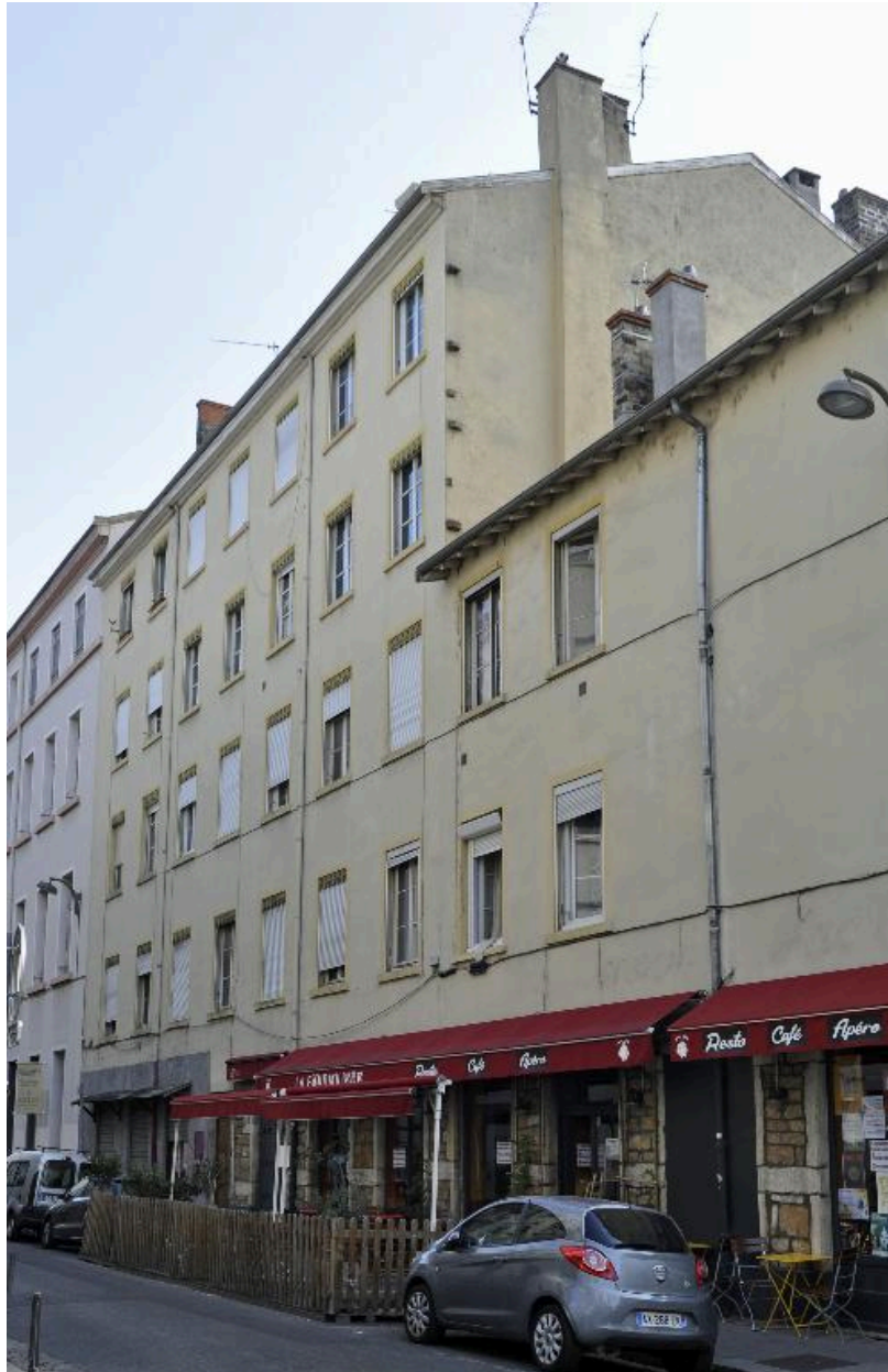
Immeuble sur rue, élévation antérieure
