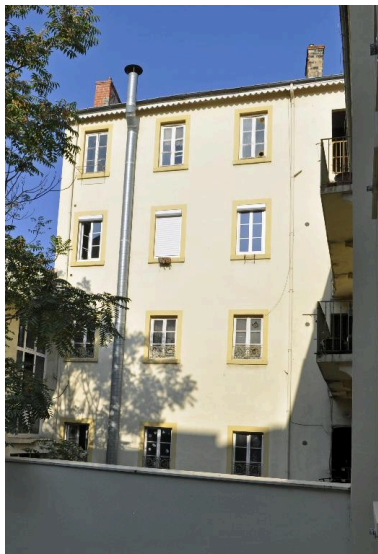
Immeuble sur rue, élévation postérieure Phot. Catherine Guégan IVR82_20156902523NUCA
