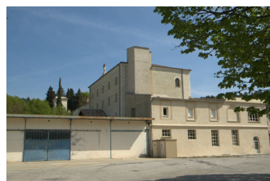
Vestiges de la chocolaterie et entrepôts Phot. Geneviève Jourdan IVR82_20102600494NUCA
