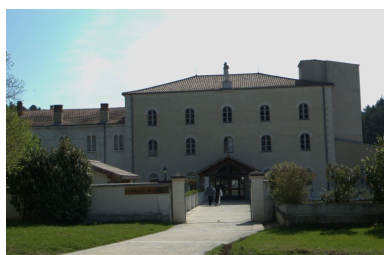
Vue depuis l'ouest de la chocolaterie. Phot. Geneviève Jourdan IVR82_20102600477NUCA
