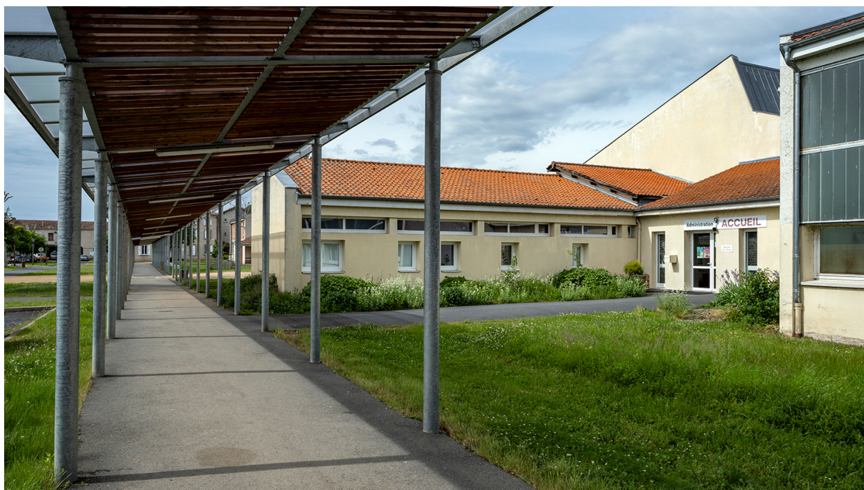
Bâtiment de l'administration ; à gauche, la galerie réalisée au titre du 1% artistique
