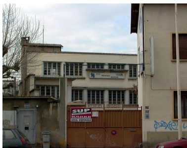
Vue des ateliers Phot. Nadine Halitim-Dubois IVR82_20016900475NUCA
