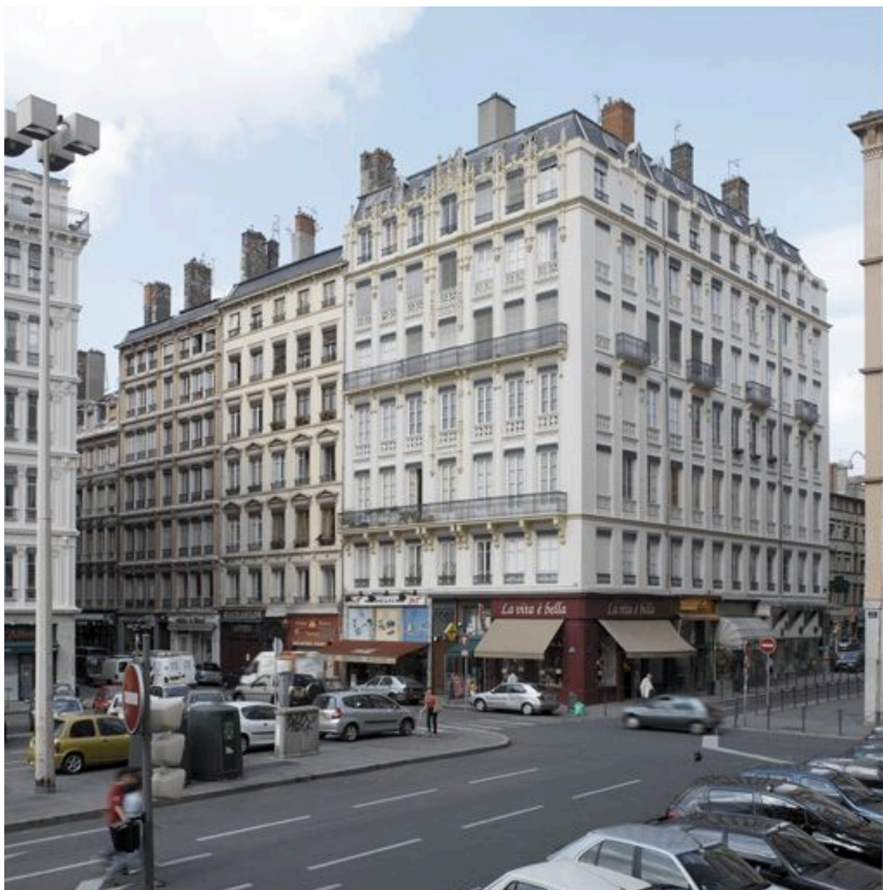
Vue générale de situation
