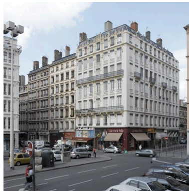
Vue générale de situation Phot. Didier Gourbin IVR82_20056901555NUCA
