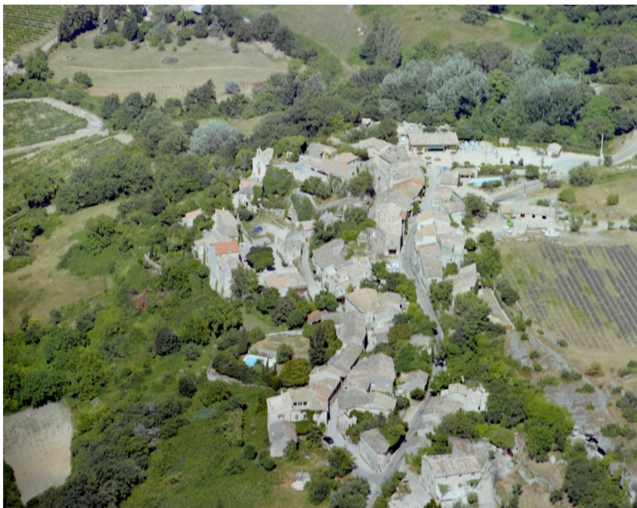
Vue aérienne, prise depuis l'ouest.
