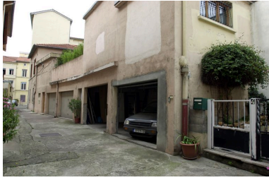
Vue générale depuis le nord Phot. Maryannick Chalabi IVR82_20096901025NUCA
