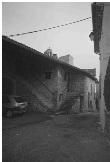
Elévations postérieures des différents corps. Phot. Geneviève Jourdan IVR82_20052600013Z
