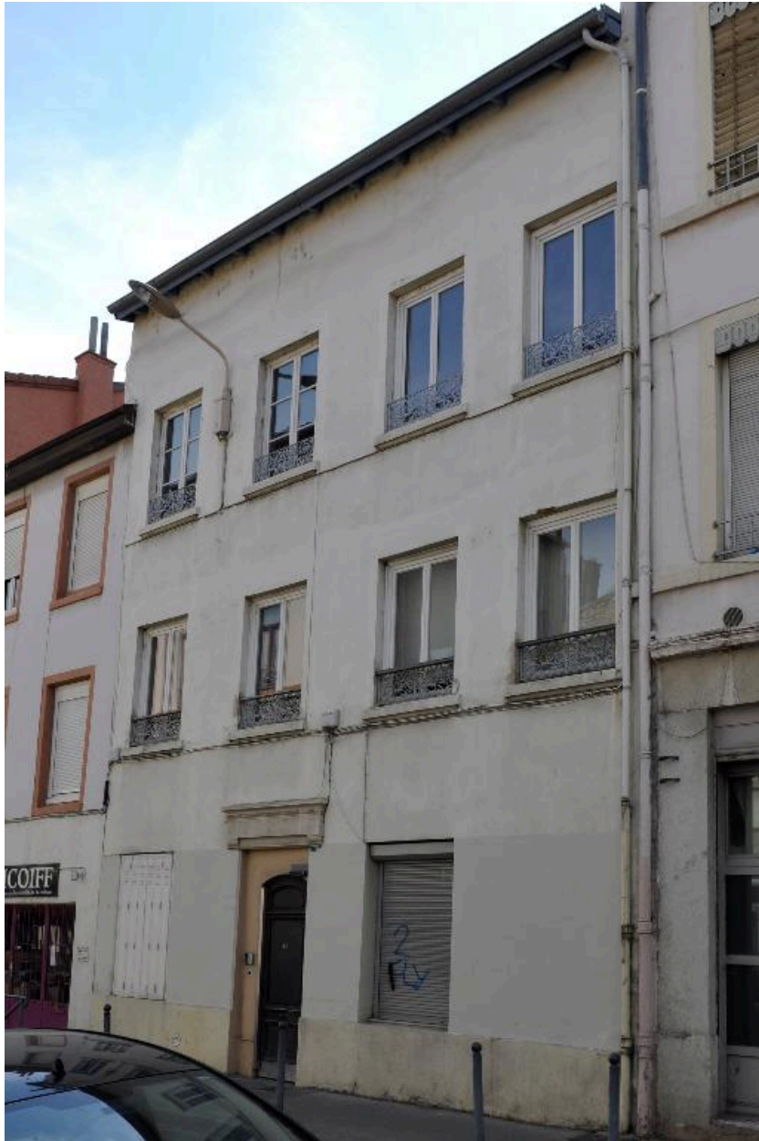
Vue générale, élévation sur rue
