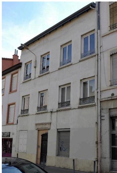
Vue générale, élévation sur rue Phot. Magali Delavenne IVR84_20176901010NUCA
