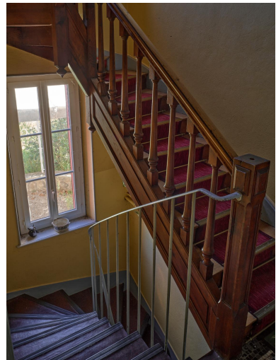
Escalier dans l'œuvre de la Villa Mon Désir. Phot. Christian Parisey IVR84_20246302237NUC4A
