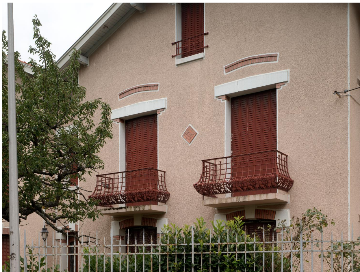
Garde-corps en ferronnerie à l'étage de la Villa Mon Désir
