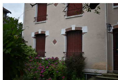
Vue du rez-de-chaussée gauche de la Villa Mon Désir Phot. Isabelle Brown IVR84_20246301996NUCA
