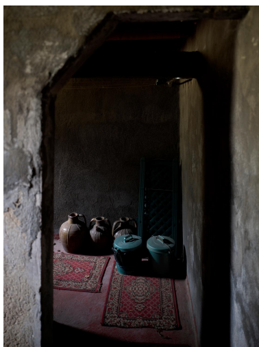
Ancienne cave au niveau du soubassement, de la Villa Mon Désir
