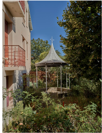
Kiosque du jardin de la Villa Mon Désir Phot. Christian Parisey IVR84_20246302233NUC4A
