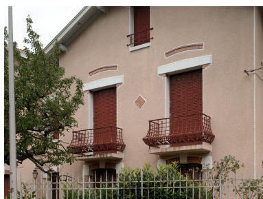
Garde-corps en ferronnerie à l'étage de la Villa Mon Désir Phot. Christian Parisey IVR84_20246301994NUC4A
