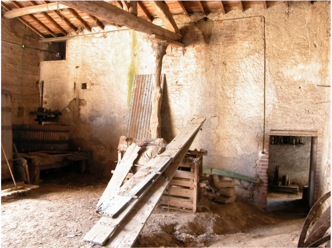
Vue intérieure du cuvage.
