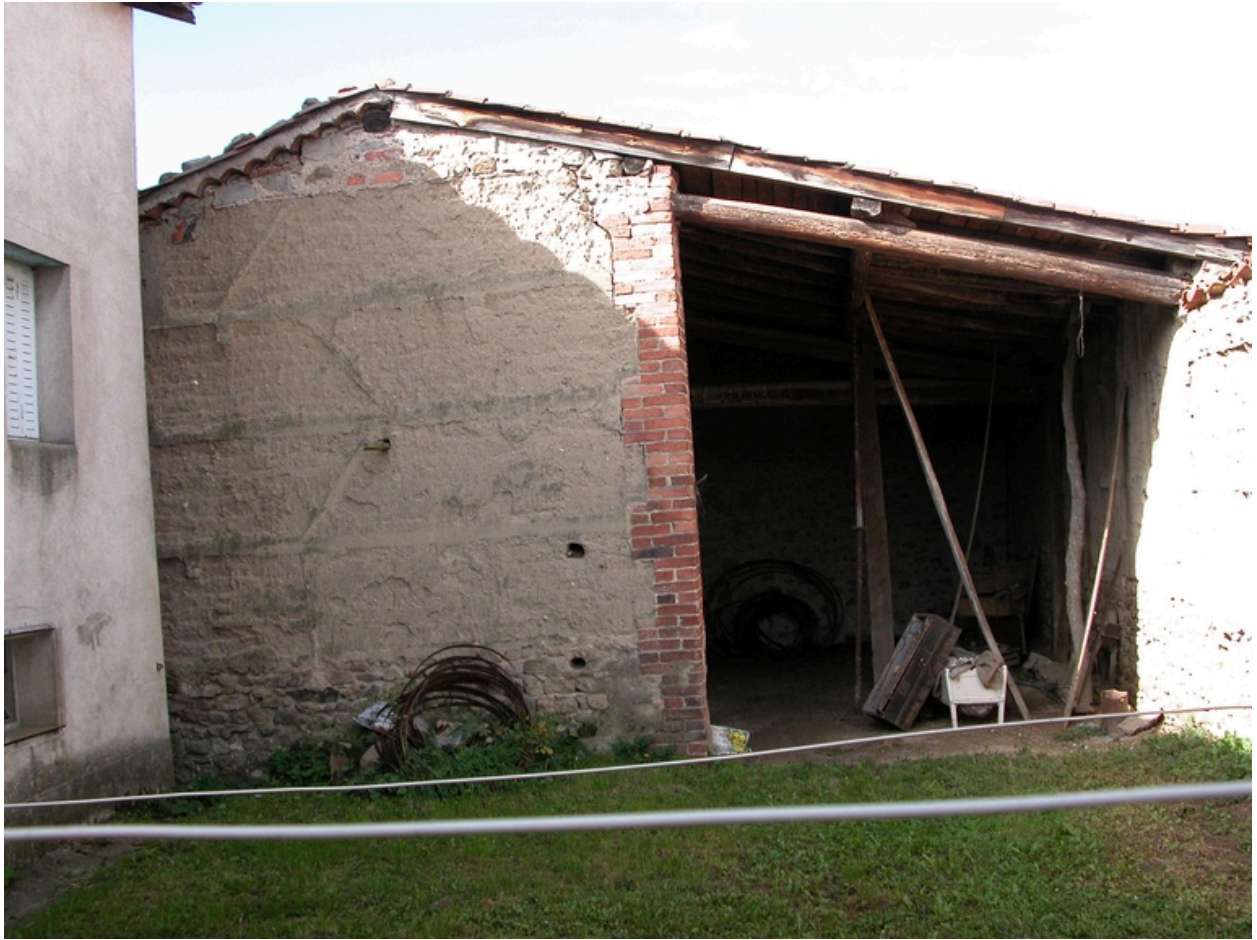
Vue de la remise-cuvage, depuis l'est.
