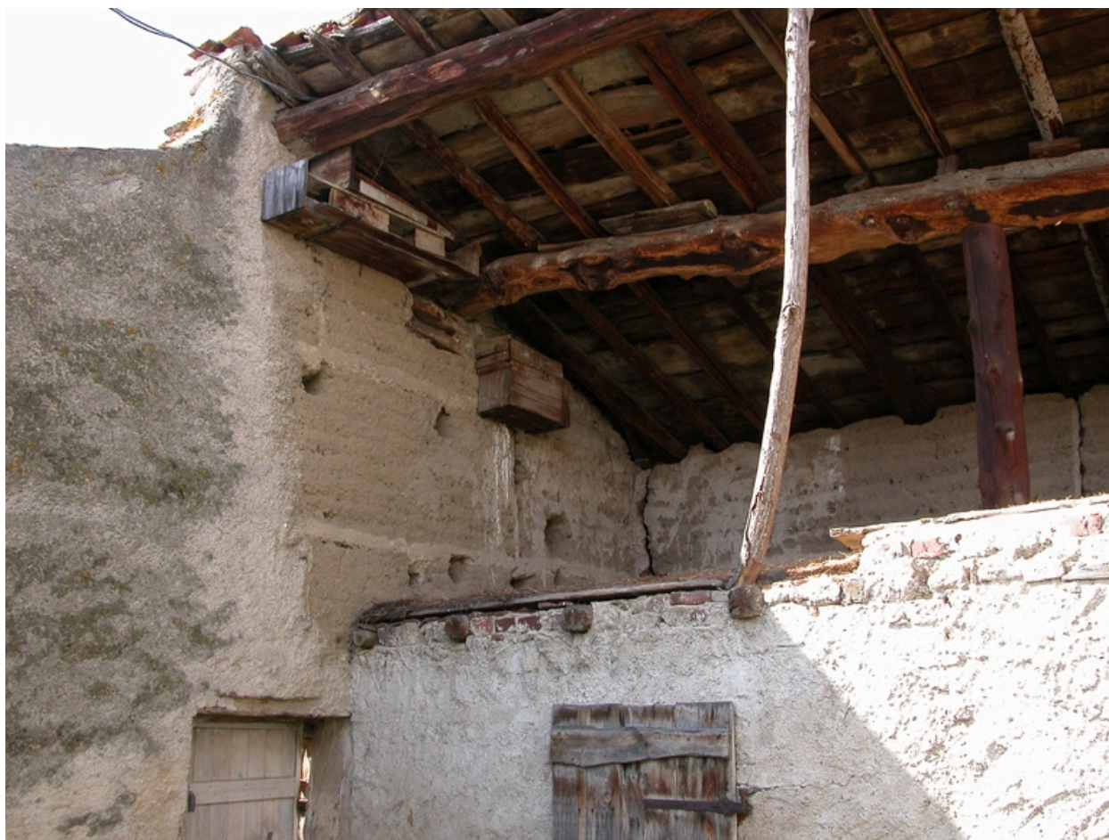
Détail des casiers à pigeons (fuiés) sous le toit du bûcher (au-dessus de la porcherie).
