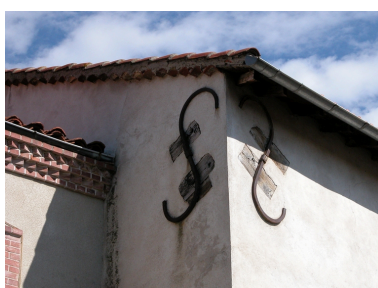
Détail des clés dans les murs du logis est. Phot. Thierry Monnet IVR82_20124201597NUCA
