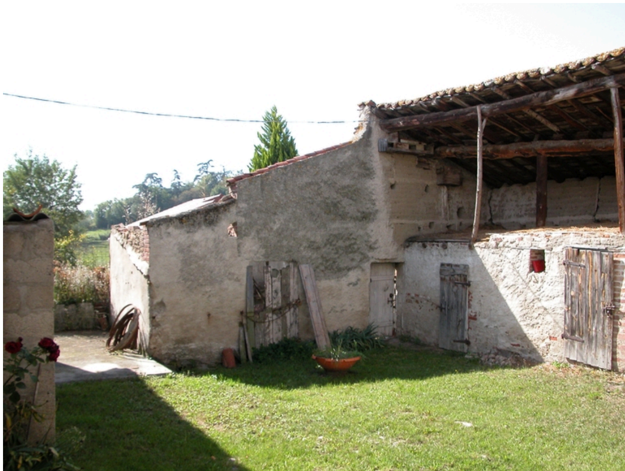
Vue de l'angle entre la porcherie et l'écurie.
