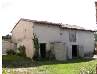
Vue de la grange-étable sud. Phot. Thierry Monnet IVR82_20124201594NUCA
