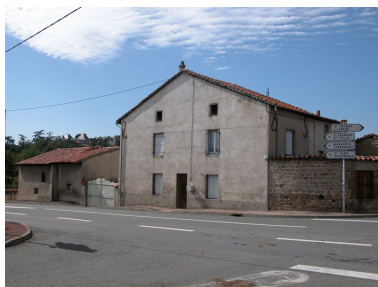
Vue générale depuis le nord-est. Phot. Thierry Monnet IVR82_20124201603NUCA
