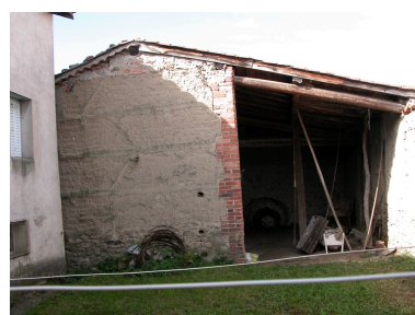
Vue de la remise-cuvage, depuis l'est. Phot. Thierry Monnet IVR82_20124201585NUCA
