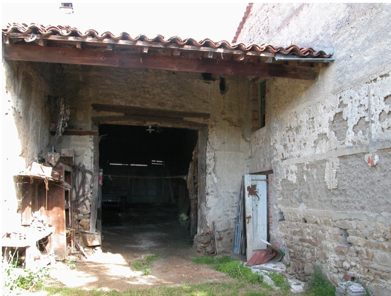
Vue de la remise située à l'ouest, depuis le sud.
