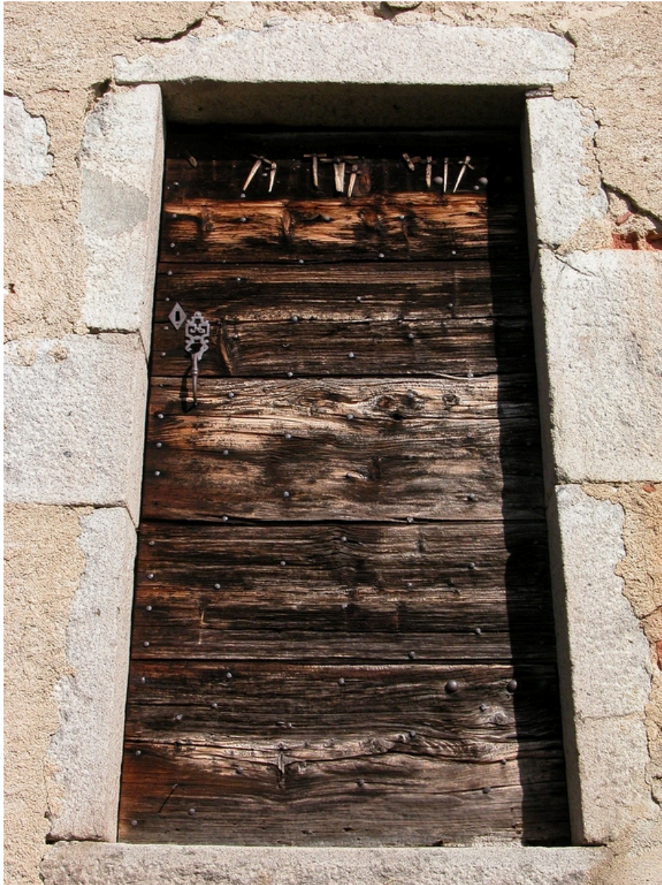
Détail de la porte haute de l'étable nord : croisettes.
