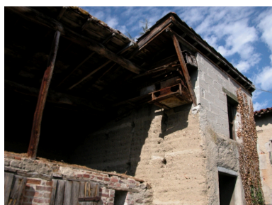
Détail des casiers à pigeons (fuiés) sous le toit de la chaudière.
