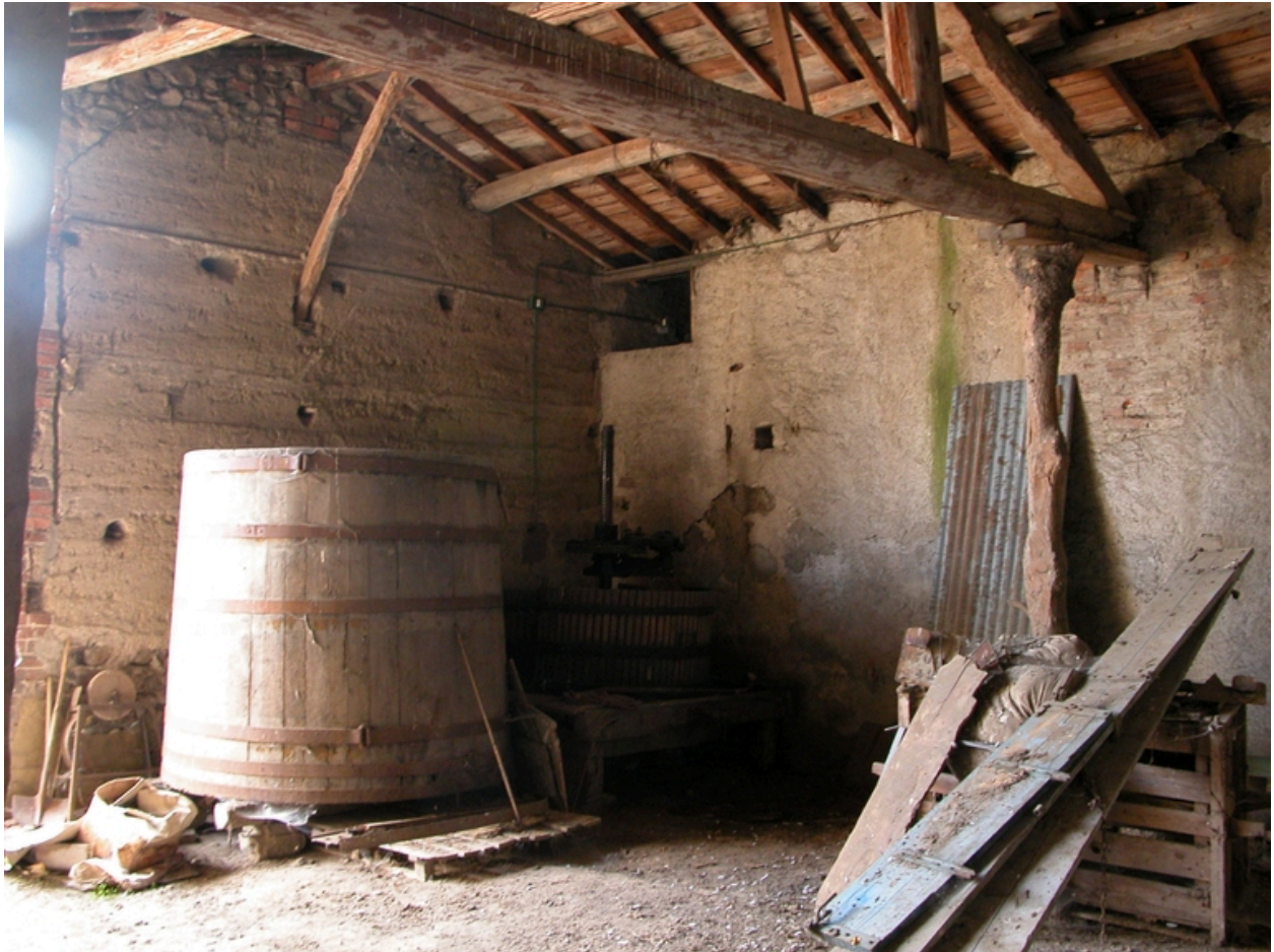
Vue intérieure du cuvage.
