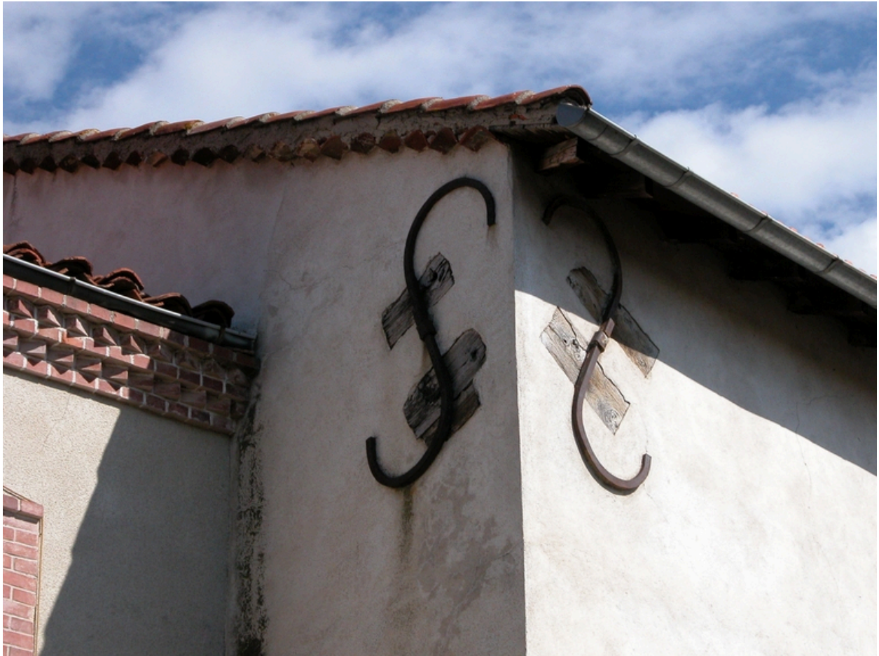
Détail des clés dans les murs du logis est.
