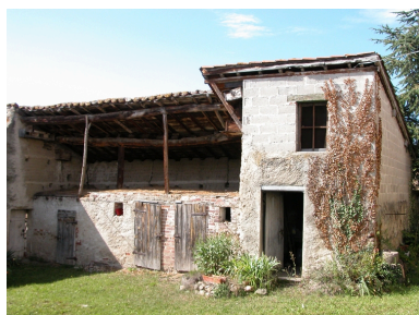
Vue de la porcherie et de la chaudière. Phot. Thierry Monnet IVR82_20124201592NUCA
