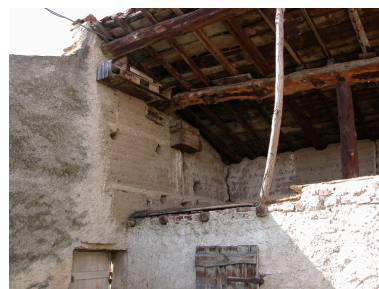
Détail des casiers à pigeons (fuiés) sous le toit du bûcher (au-dessus de la porcherie). Phot. Thierry Monnet IVR82_20124201595NUCA
