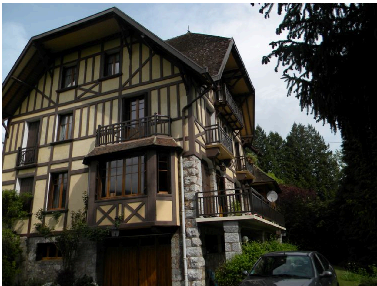
Vue de la façade sud.
