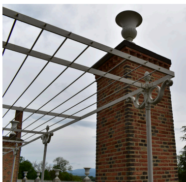
Détail rebord haut Phot. Maryse Durin-Tercelin IVR84_20226300640NUCA
