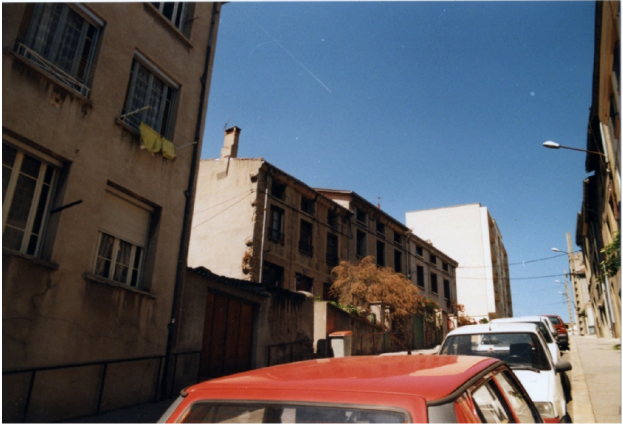
Vue d'ensemble depuis le sud-ouest. Etat en 1996
