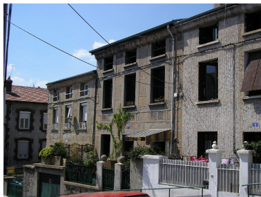
Vue d'ensemble depuis le sud-est Phot. Cendrine Sanquer IVR82_20084200537NUCA
