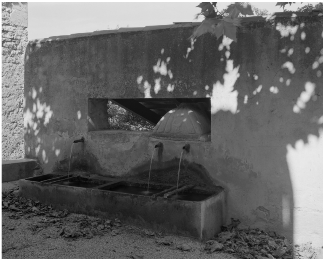
Vue d'ensemble de la fontaine-abreuvoir adossée au lavoir.
