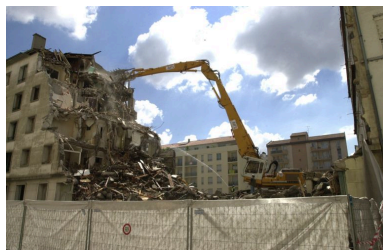
Vue de l'immeuble en cours de destruction Phot. François Blanchetière IVR82_20016901995NUCA
