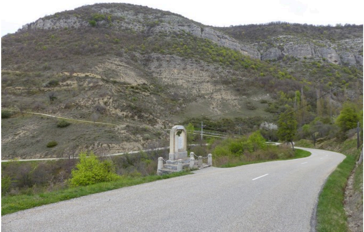
Vue de situation prise du sud-est.
