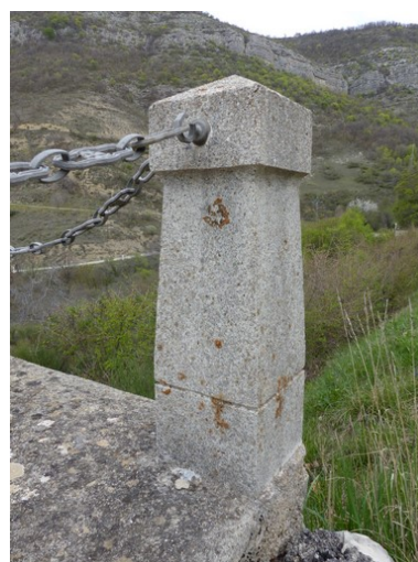
Pilier de la clôture. Phot. Alexeï Laurent IVR84_20162600184NUCA
