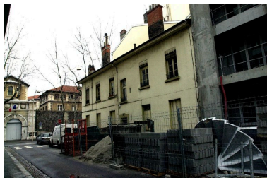
Élévation, rue Quivogne Phot. Maryannick Chalabi IVR82_20016900141NUCA
