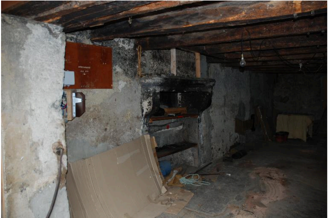
Bâtiment est, partie centrale : vue intérieure du fournil ; à gauche, cheminée du four.
