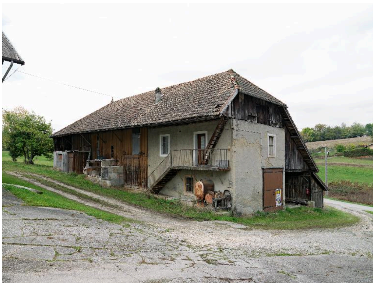
Vue d'ensemble du bâtiment nord.
