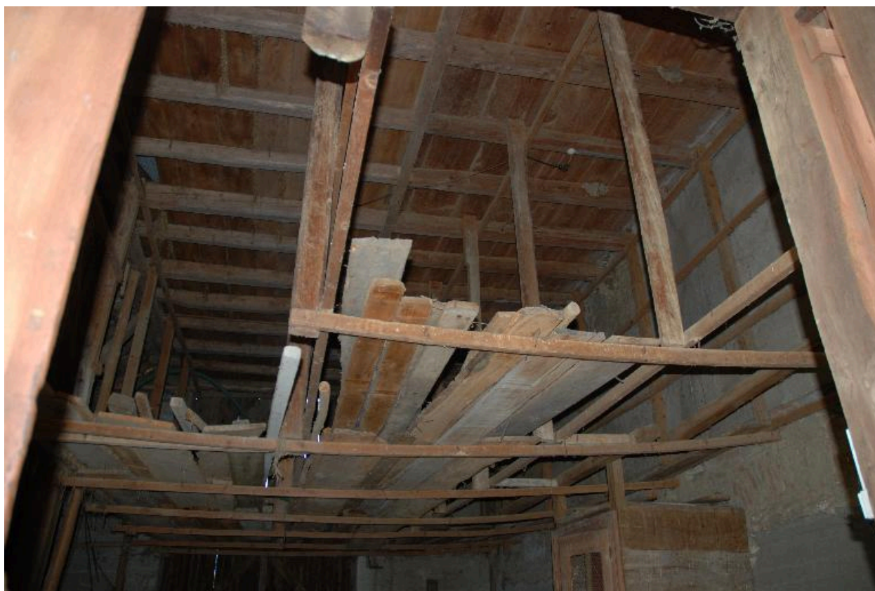
Bâtiment est, partie centrale, vue intérieure du séchoir à tabac : perches pour le séchage.
