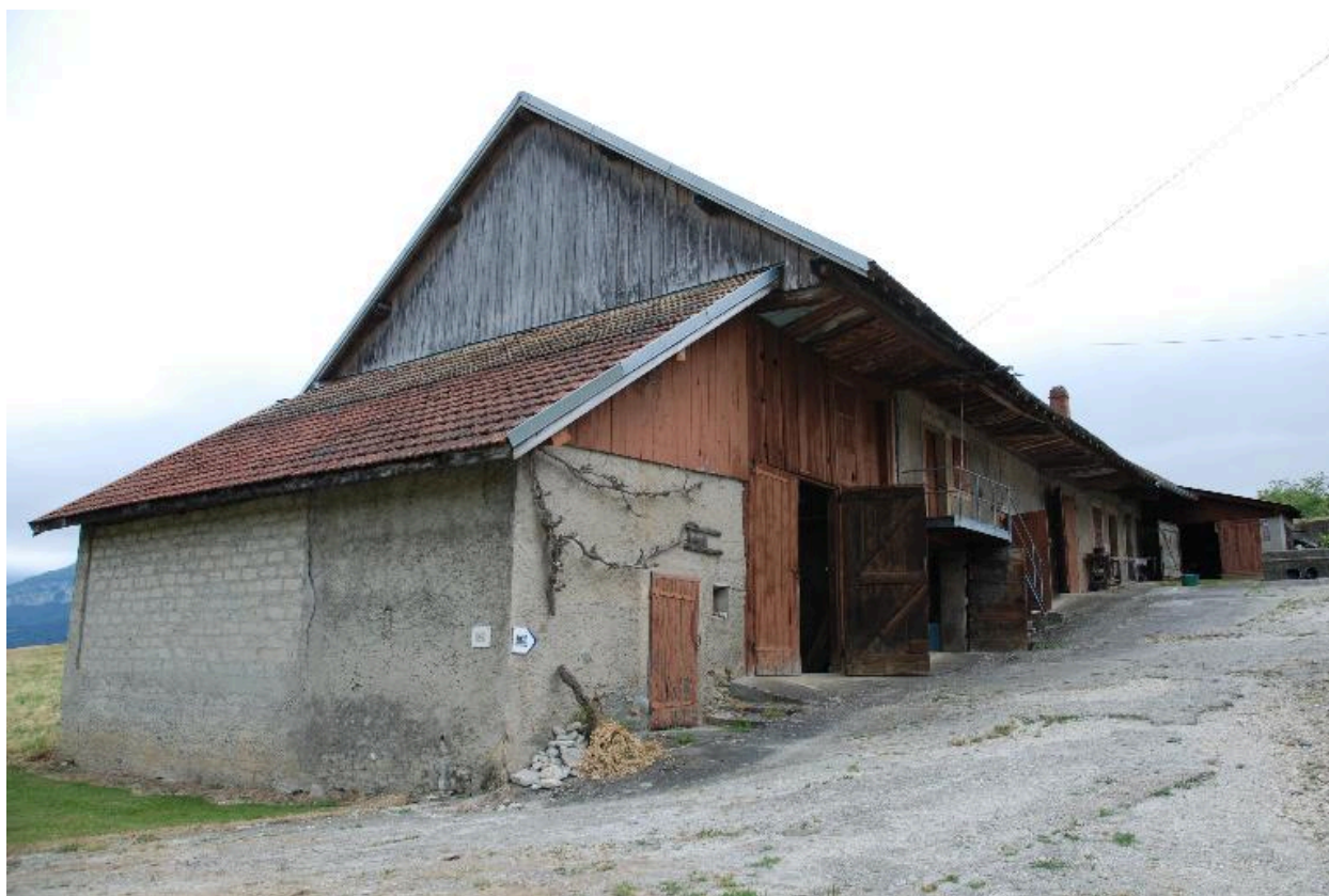
Bâtiment est, vue d'ensemble.
