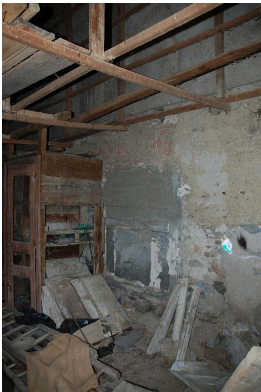
Bâtiment est, partie centrale, vue intérieure du séchoir à tabac : revers de l'entrée du four à pain (la voûte est détruite).
