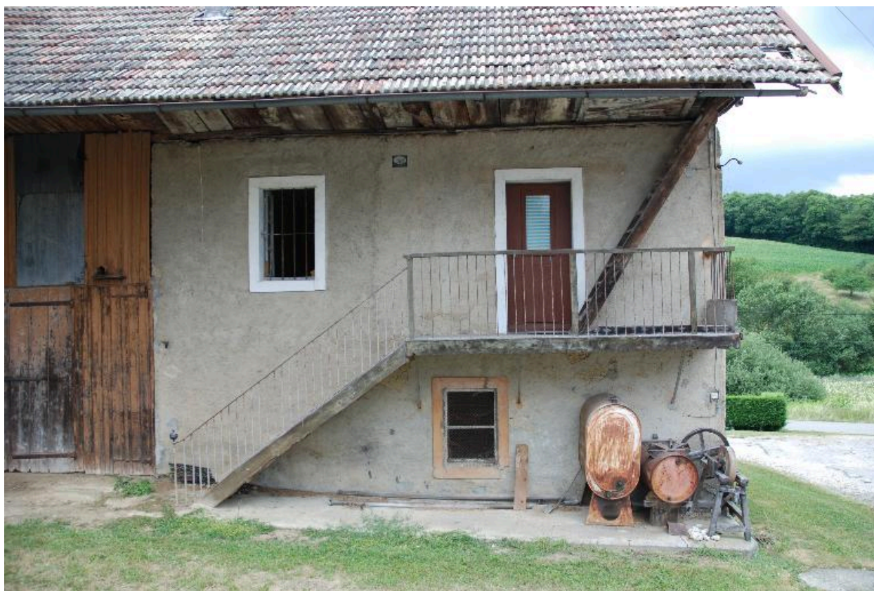
Détail du bâtiment nord : habitation.
