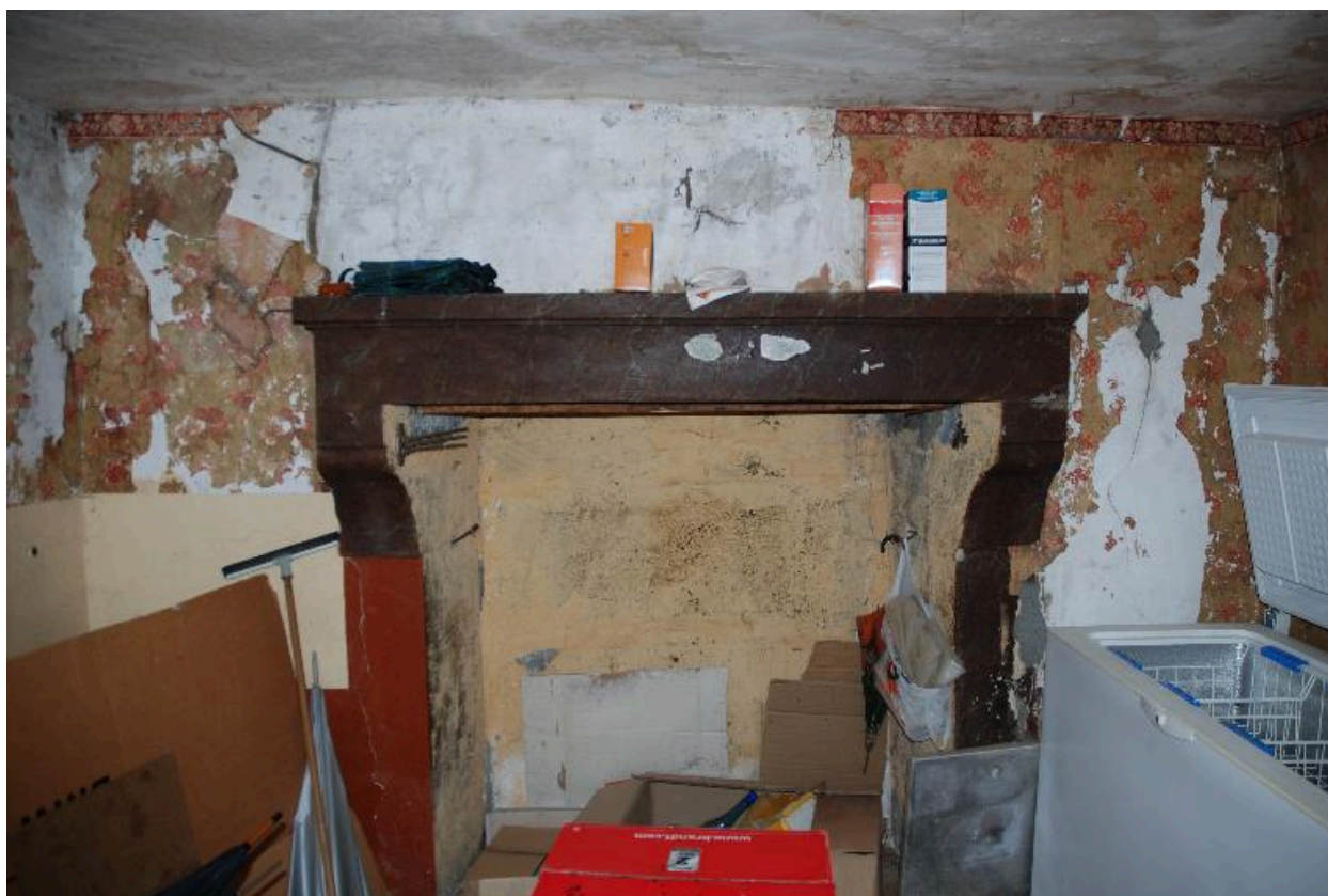
Bâtiment est, partie amont : cheminée de la cuisine nord.
