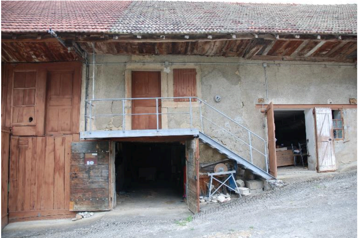
Bâtiment est, partie centrale : étable, fournil avec chambre au-dessus, séchoir à tabac (de droite à gauche).
