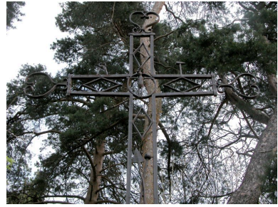
Détail de la face avant du croisillon. Phot. Thierry Monnet IVR82_20114201766NUCA
