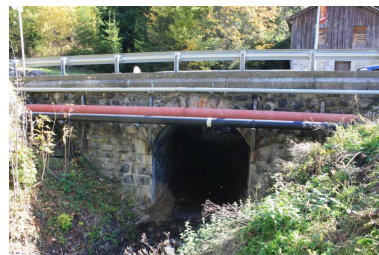
Pont du petit Nant, face aval IVR84_20197401268NUCA
