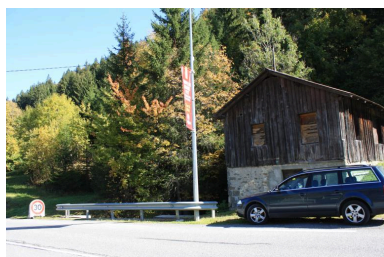
Pont du petit Nant, Contexte Phot. Benoît Huraut IVR84_20207401054NUCA
