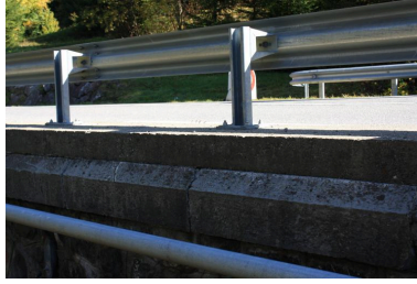
Pont du petit Nant, détails plinthe, revêtement et glissière Phot. Benoît Huraut IVR84_20207401058NUCA
