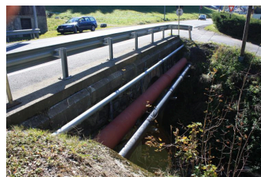
Pont du petit Nant, chaussée et garde corps Phot. Benoît Huraut IVR84_20207401056NUCA
