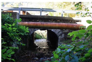
Pont du petit Nant, face amont Phot. Benoît Huraut IVR84_20207401055NUCA
