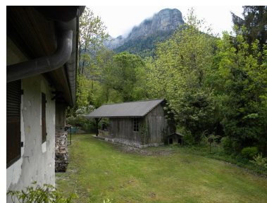
Vue de la cour à l'arrière du martinet. Phot. Jérôme Daviet IVR82_20107402903NUCA
