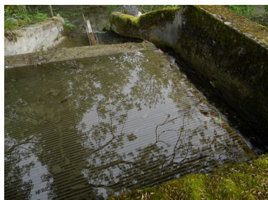
Vue de la grille formant la chute, et du trop-plein retournant dans l'Ire. Phot. Jérôme Daviet IVR82_20107402908NUCA
