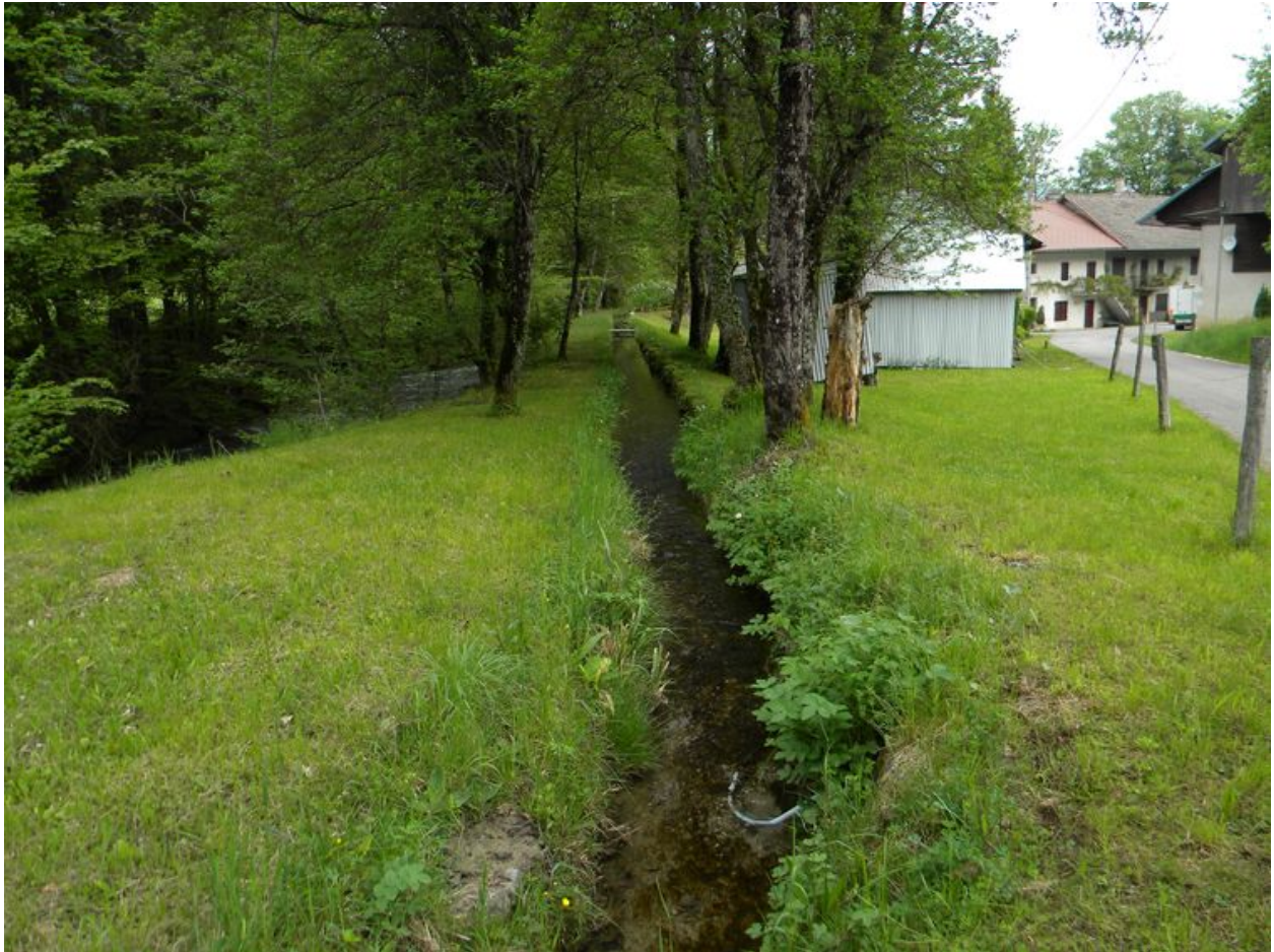
Vue du bief en amont du martinet.
