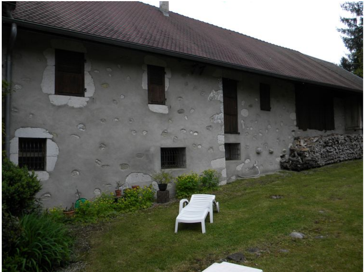
Vue de la façade arrière du martinet.
