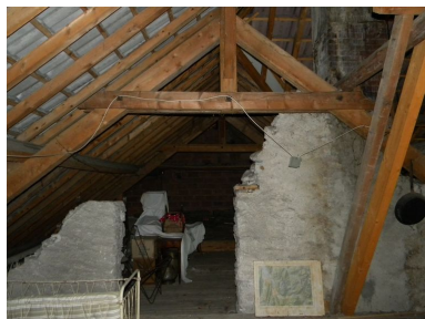
Vue du grenier et de la charpente. Phot. Jérôme Daviet IVR82_20107402904NUCA
