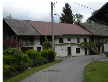
Vue générale de l'ancien martinet Bertholio en venant de la Combe d'Ire. Phot. Jérôme Daviet IVR82_20107402900NUCA
