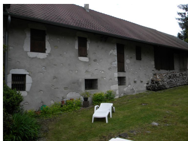
Vue de la façade arrière du martinet. Phot. Jérôme Daviet IVR82_20107402901NUCA
