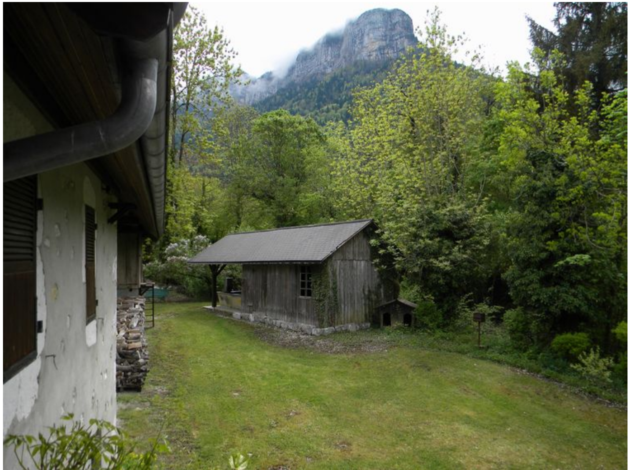
Vue de la cour à l'arrière du martinet.
