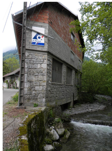
Vue de la prise d'eau dans l'Ire. Phot. Jérôme Daviet IVR82_20107402910NUCA
