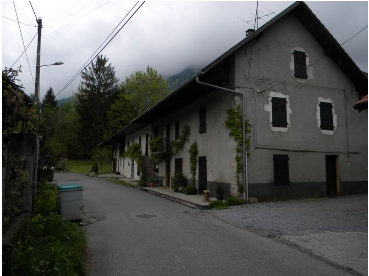
Vue générale du martinet depuis la route.
