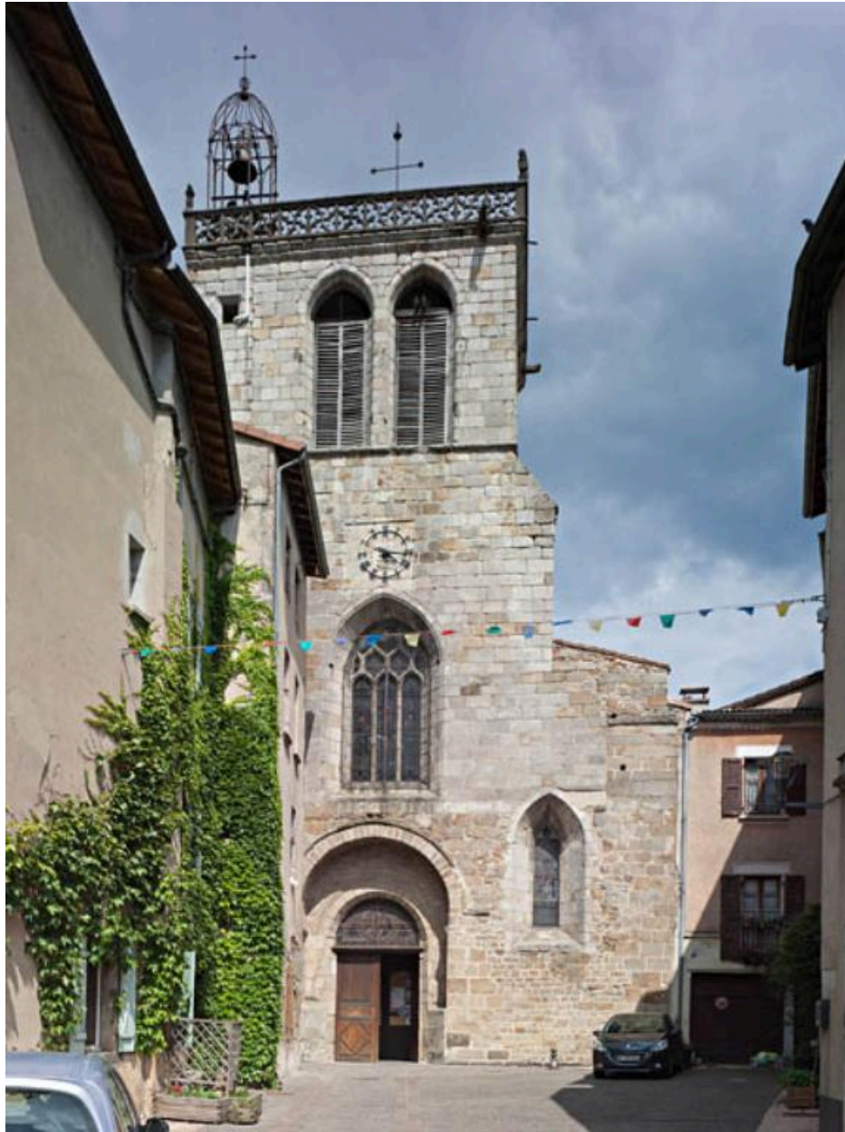
Vue générale de la façade occidentale.
