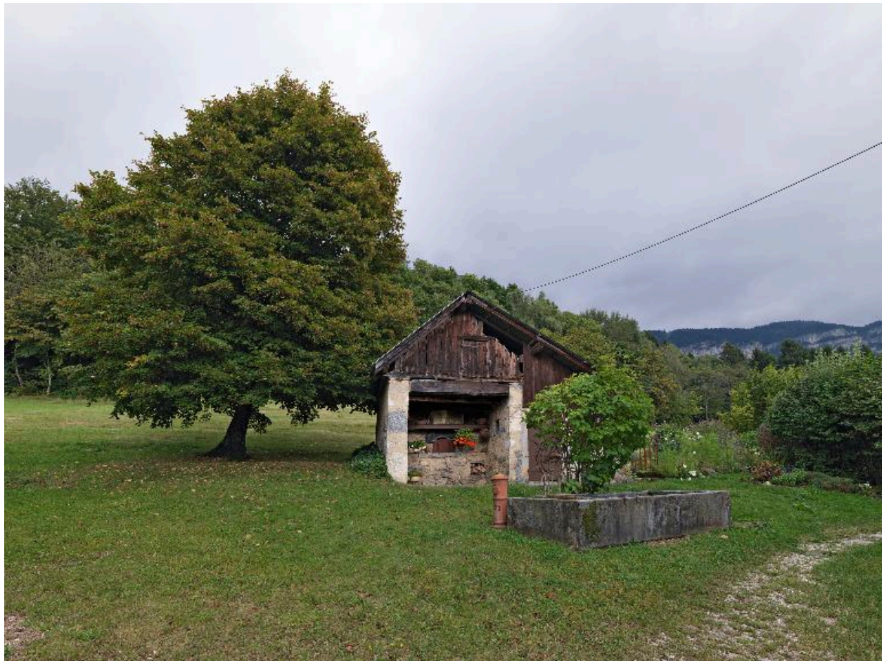
Vue d'ensemble du four à pain dans son site.
