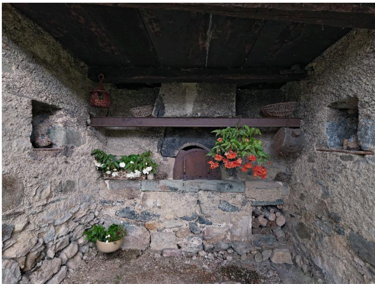
Vue d'ensemble intérieure du four à pain
