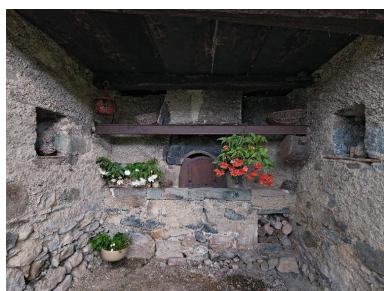
Vue d'ensemble intérieure du four à pain
