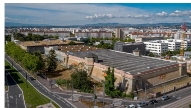
Vue d'ensemble des réservoirs du 8e arrondissement (drône)
