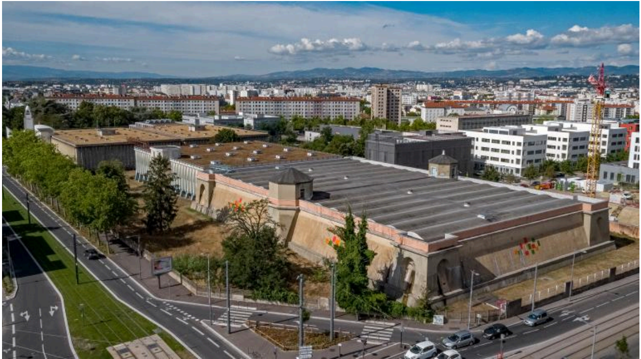
Vue d'ensemble des réservoirs du 8e arrondissement (drône)
