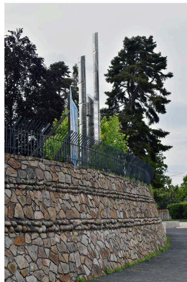
Vue depuis l'extérieur et depuis le sud Phot. Catherine Guégan IVR84_20254300189NUCA
