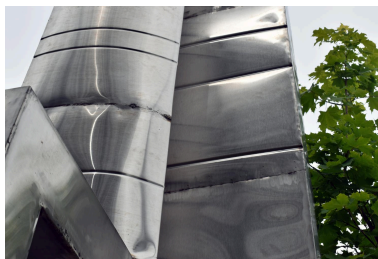
Détail des assemblages par soudure Phot. Catherine Guégan IVR84_20254300187NUCA
