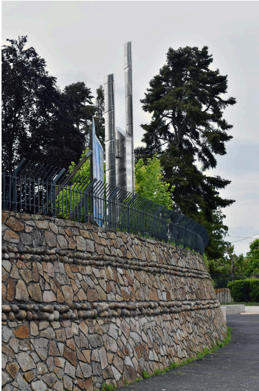
Vue depuis l'extérieur et depuis le sud
