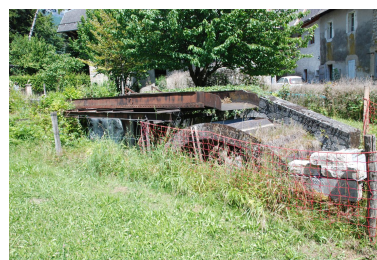
Vue du bief et de la roue. Phot. Thierry Monnet IVR84_20247300734NUCA
