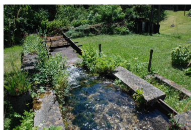
Vue du bief. Phot. Thierry Monnet IVR84_20247300733NUCA
