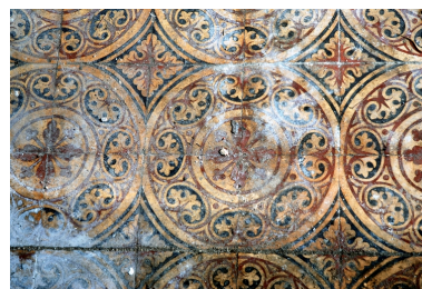
Détail du carrelage en carreaux de ciment Phot. Catherine Guégan IVR82_20123800154NUCA
