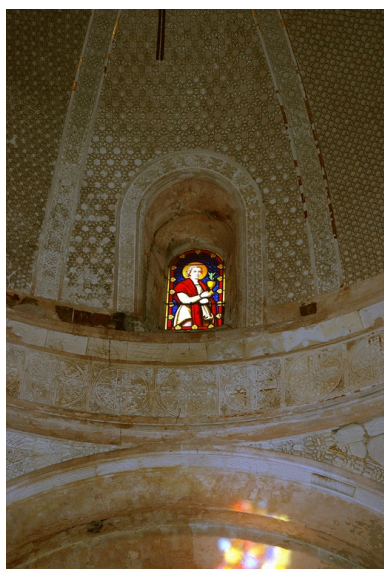
Coupole, détail de la lucarne avec le vitrail de saint Jean l'Evangeliste Phot. Catherine Guégan IVR82_20123800152NUCA
