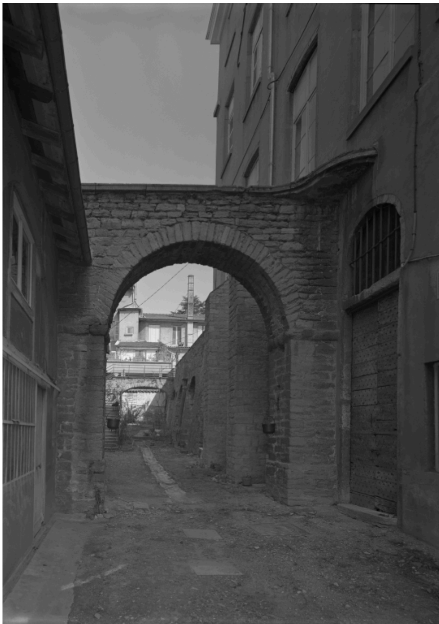
Elévation latérale droite, avec portail et murs de soutènement de la terrasse.
