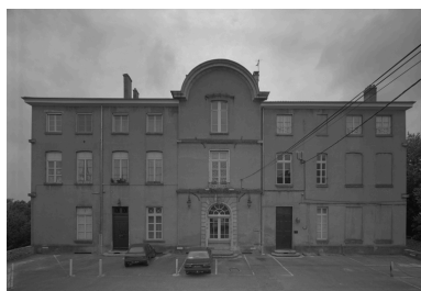
Façade antérieure sur cour. Phot. Eric Dessert IVR82_19910100518P
