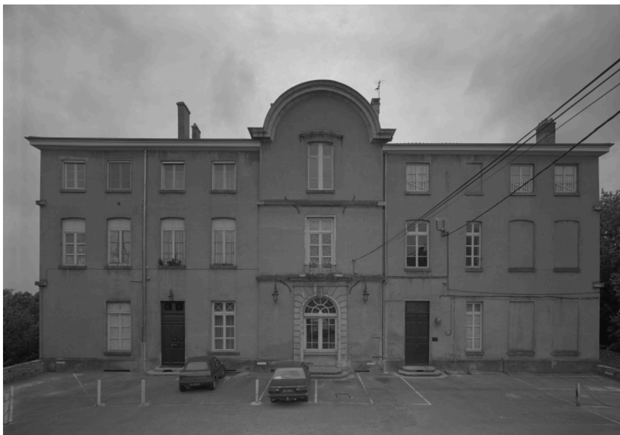
Façade antérieure sur cour.
