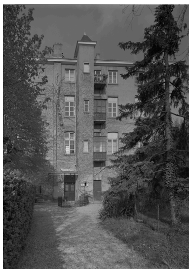
Elévation latérale gauche. Phot. Jean-Marie Refflé, Phot. Eric Dessert IVR82_19910100523P
