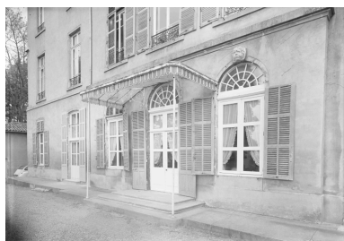
Façade sur jardin, détail premier niveau. Phot. Jean-Marie Refflé, Phot. Eric Dessert IVR82_19910100522P
