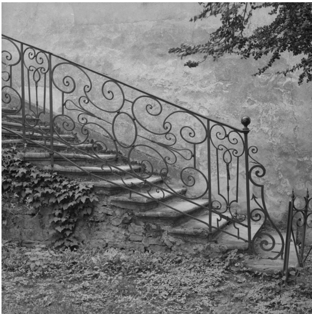
Rampe de l'escalier extérieur au niveau du palier, détail.
