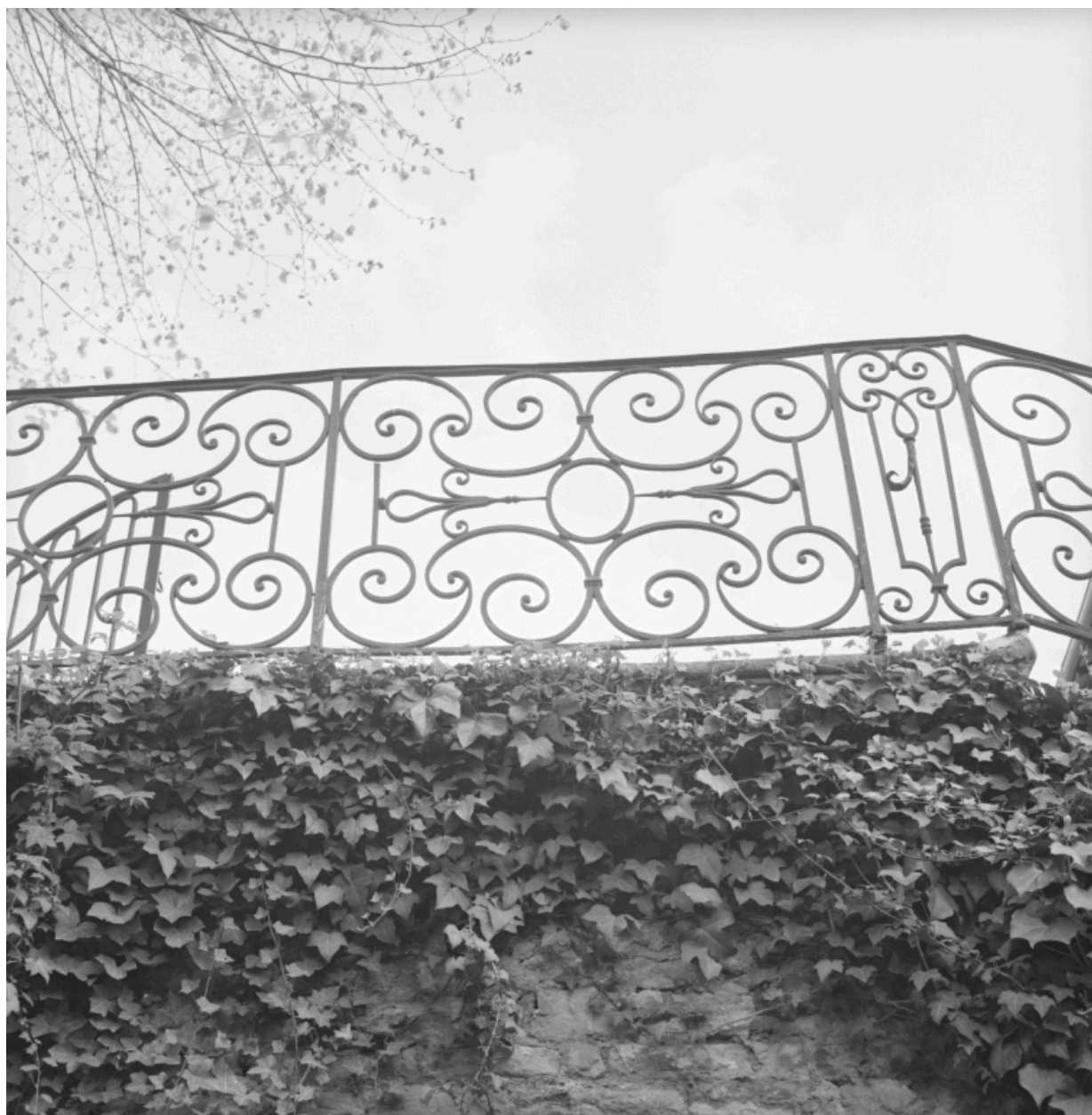
Départ de la rampe en fer forgé de l'escalier extérieur.
