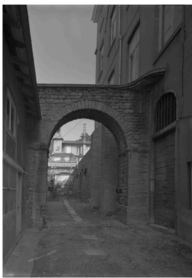
Elévation latérale droite, avec portail et murs de soutènement de la terrasse. Phot. Jean-Marie Refflé, Phot. Eric Dessert
