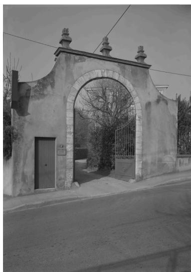
Portail latéral sur la rue de la Gare. Phot. Jean-Marie Refflé, Phot. Eric Dessert IVR82_19910100519P
