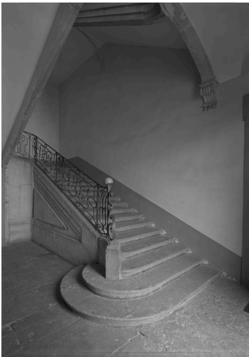
Escalier d'honneur, première volée.
