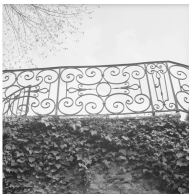
Départ de la rampe en fer forgé de l'escalier extérieur. Phot. Jean-Marie Refflé, Phot. Eric Dessert IVR82_19910100397X
