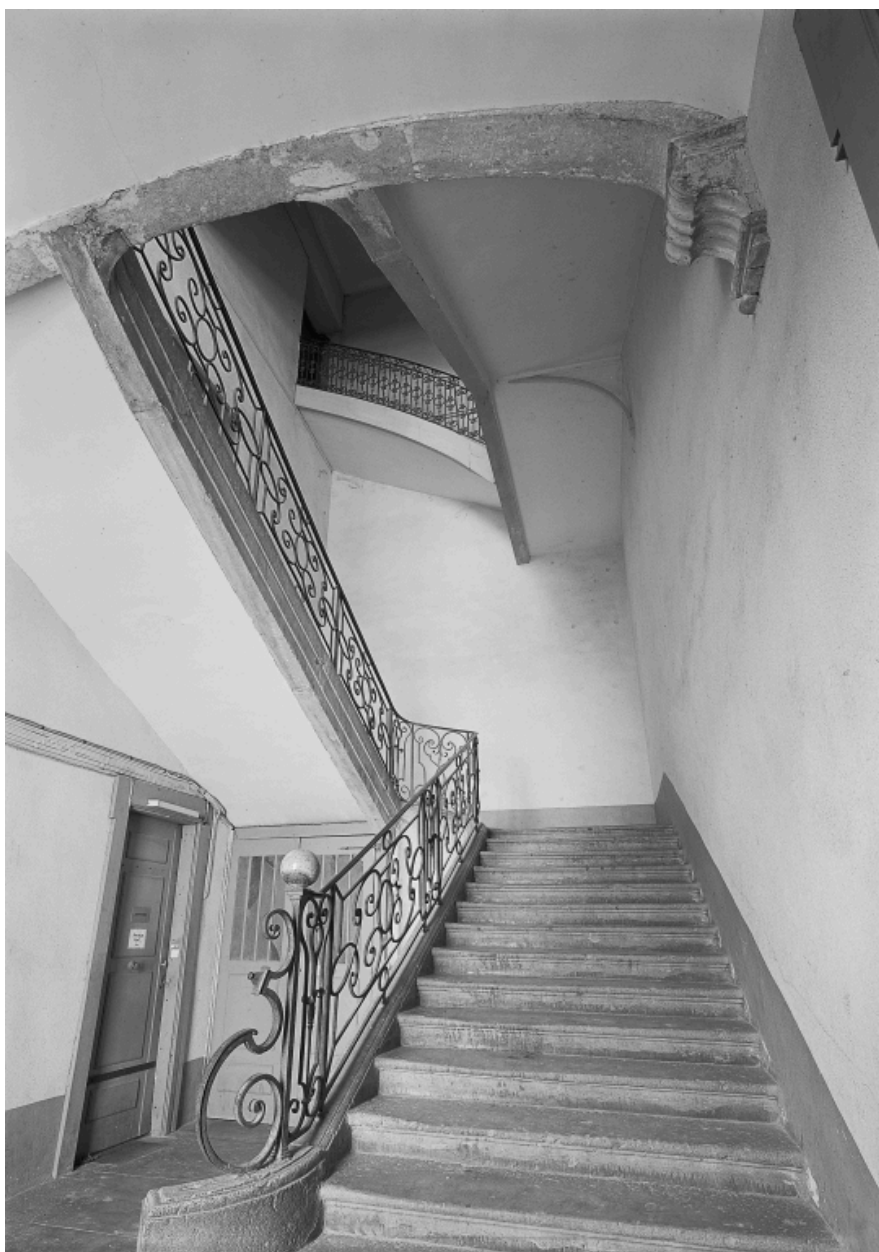
Escalier d'honneur, vue d'ensemble.
