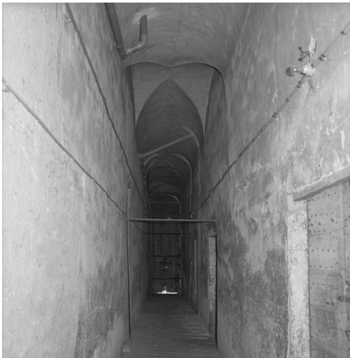
Etage de soubassement : couloir longitudinal médian.
