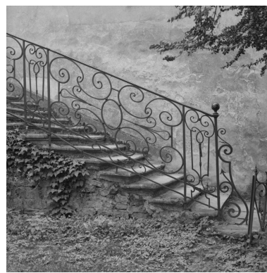
Rampe de l'escalier extérieur au niveau du palier, détail. Phot. Jean-Marie Refflé, Phot. Eric Dessert IVR82_19910100398X
