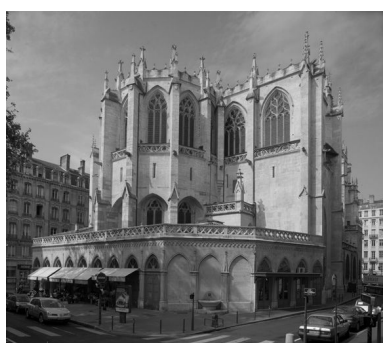
Place, vue générale du côté ouest Phot. Eric Dessert IVR82_20056901702NUC
