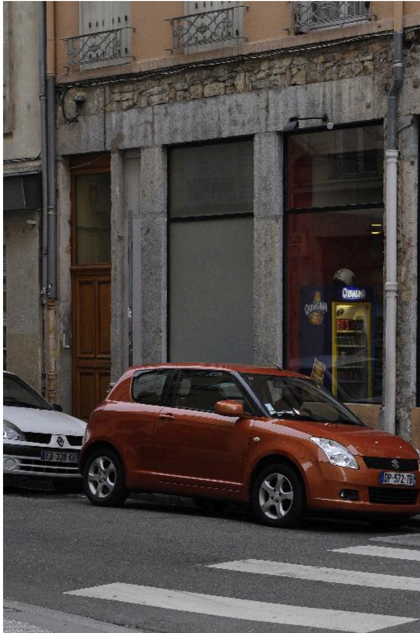
Détail du soubassement et de la porte d'entrée
