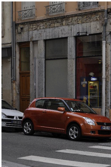
Détail du soubassement et de la porte d'entrée Phot. Magali Delavenne IVR84_20166902097NUCA
