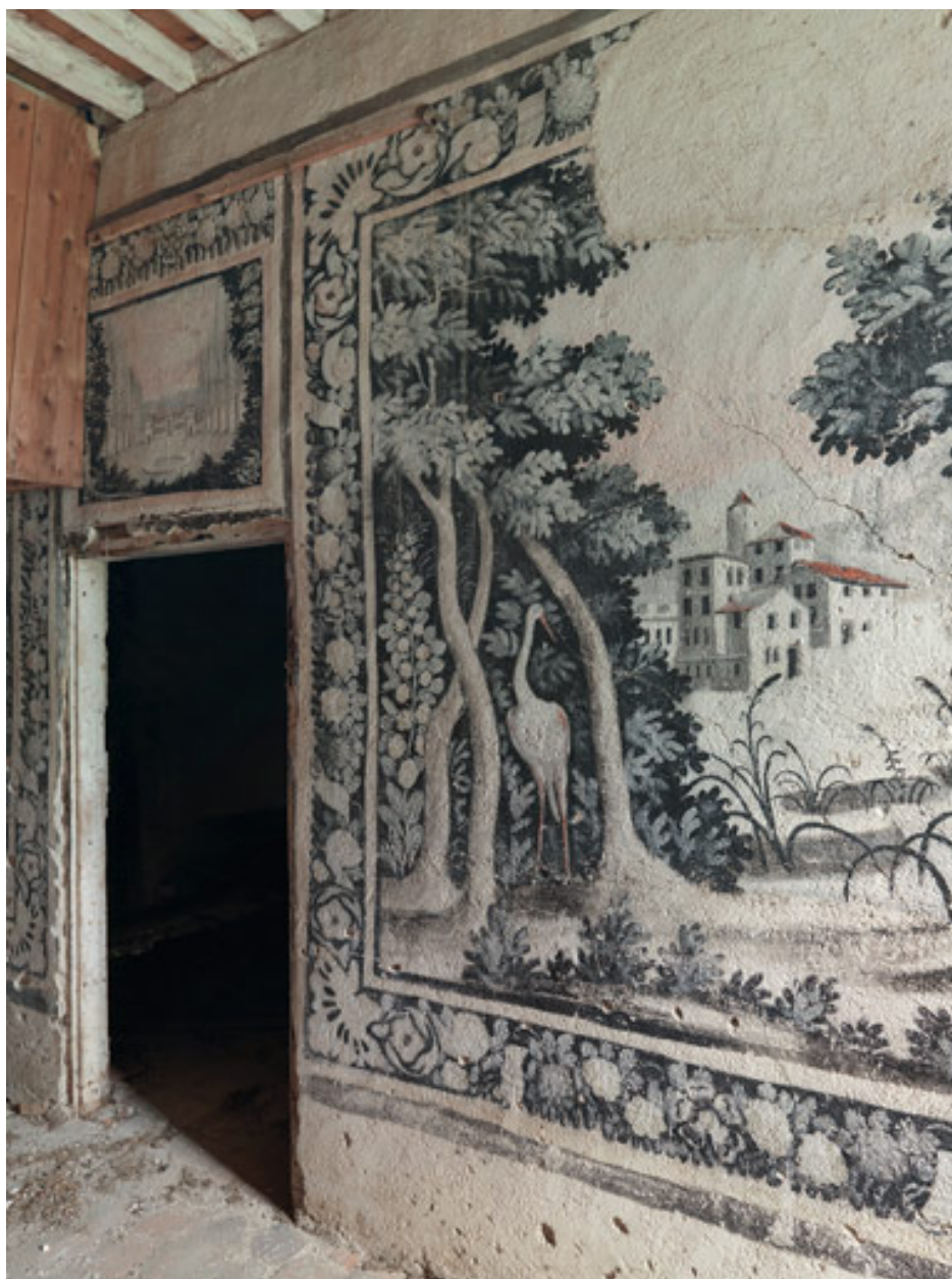
Porte et panneau du mur est.
