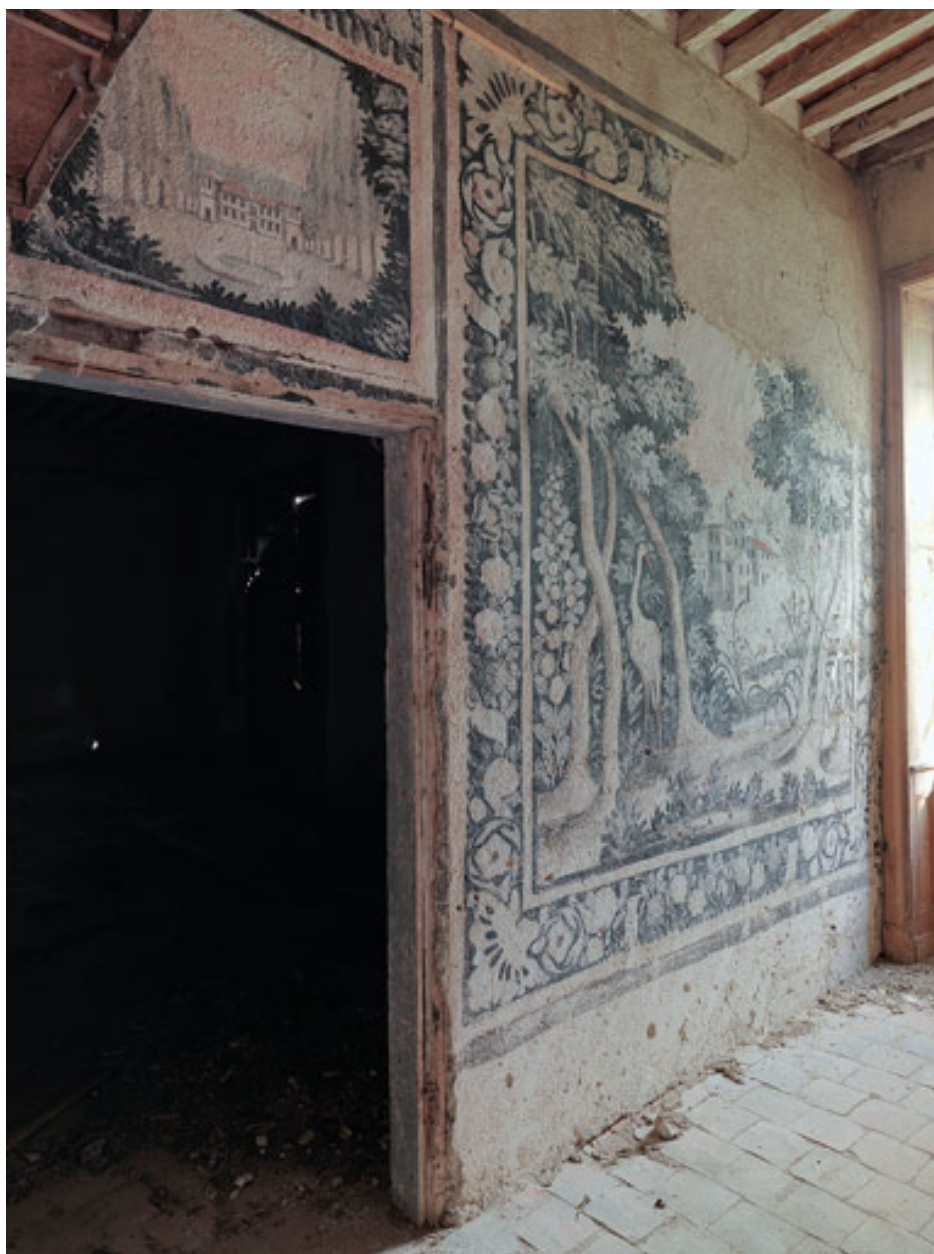
Porte et panneau du mur est.
