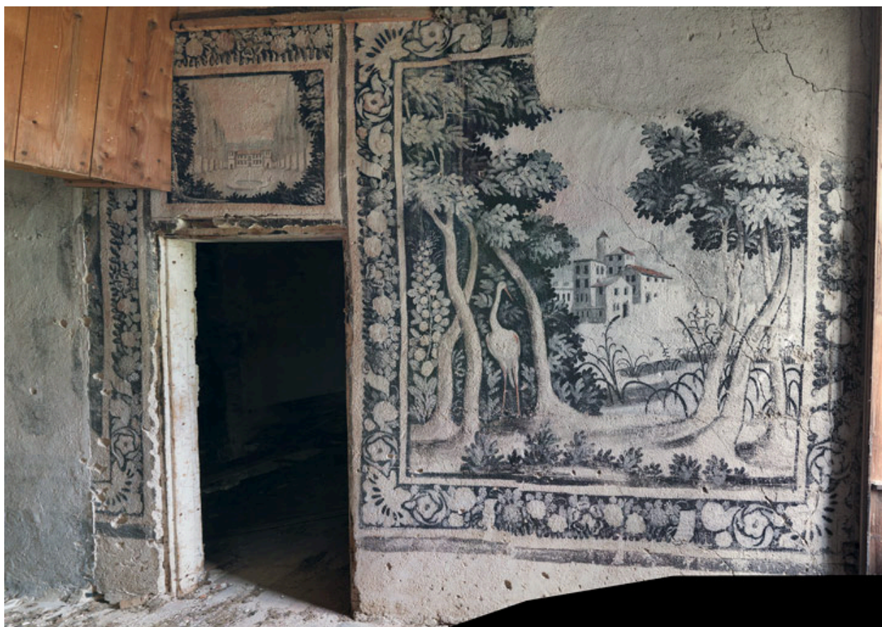
Vue du mur est.
