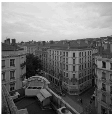
Vue d'ensemble vers le sud depuis le toit du Grand Bazar Phot. Eric Dessert IVR82_20046901121NUC
