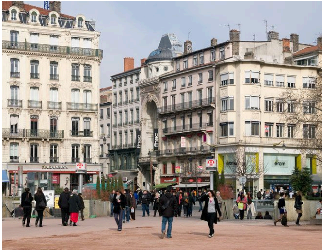
Le débouché de la rue de la République sur la place Le Viste et la place Bellecour, rive impaire. A l'arrière-plan, l'édifice construit par le tandem Emile Guimet - Jules Chatron (actuellement FNAC)
