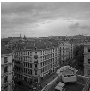
Vue d'ensemble vers le nord, depuis le toit du Grand Bazar Phot. Eric Dessert IVR82_20046901119NUC
