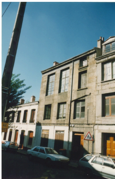
Elévation principale depuis le nord Phot. Cendrine Sanquer IVR82_19974202092ZE
