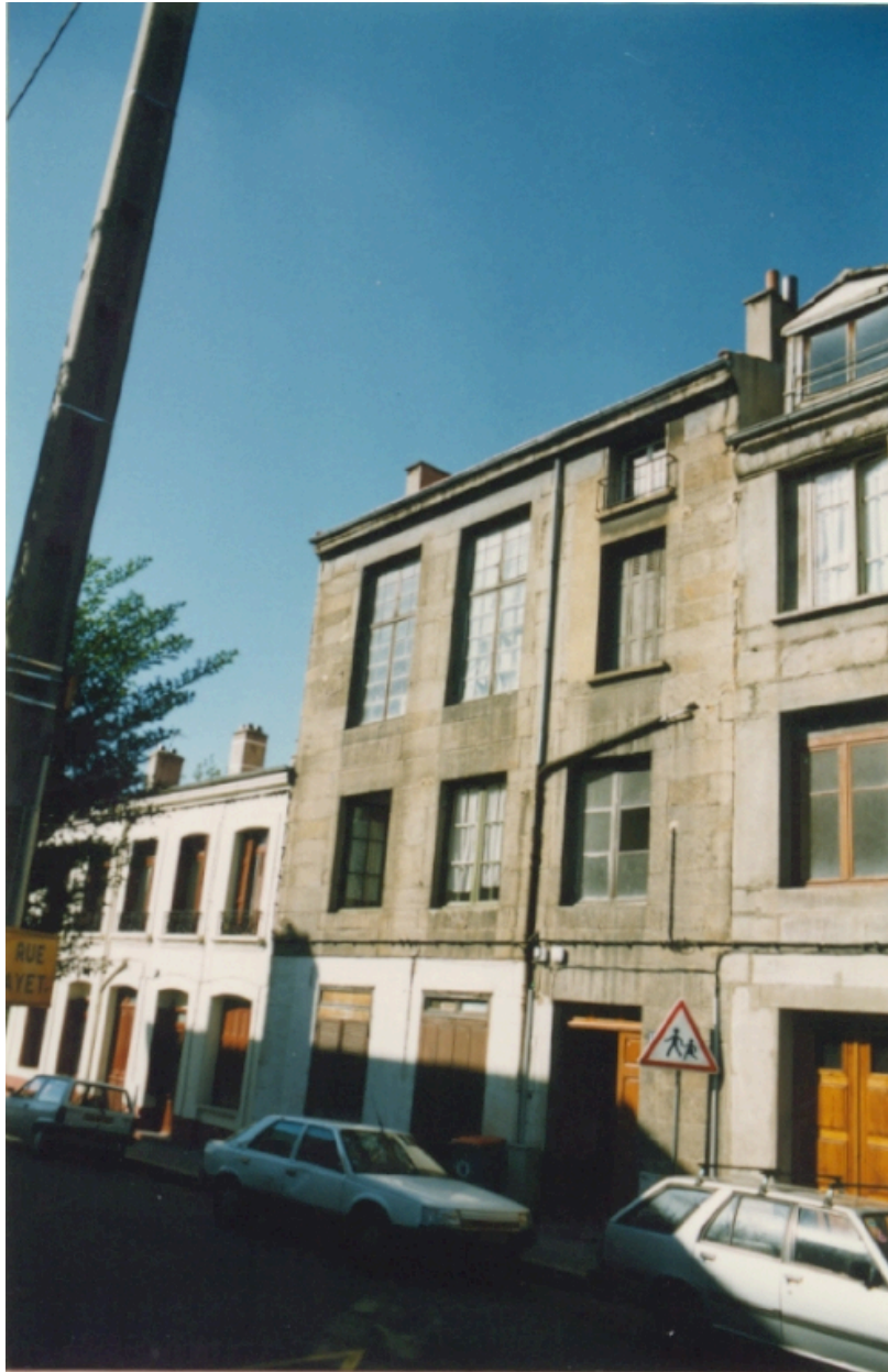
Elévation principale depuis le nord
