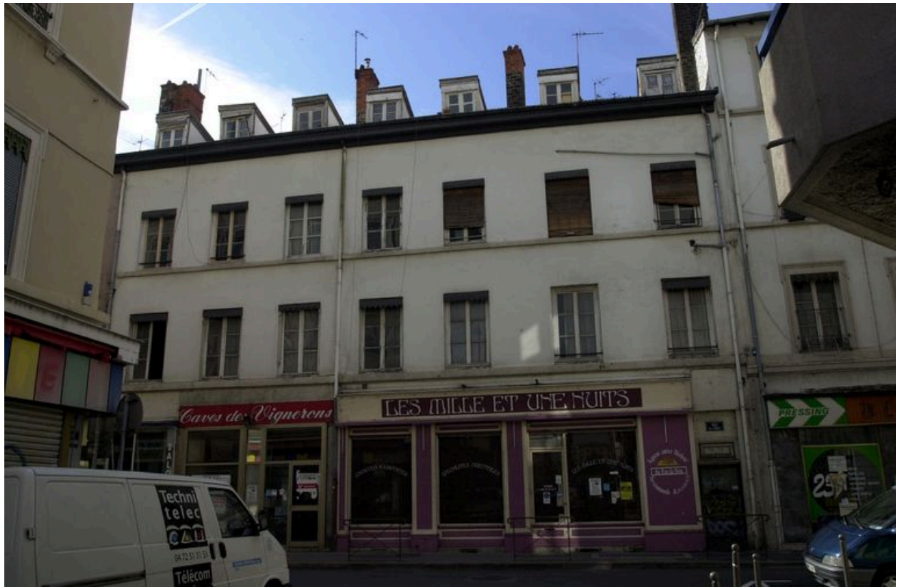
Elévation sur rue du n°72
