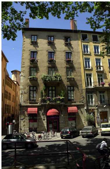
Élévation quai Romain-Rolland Phot. Véronique Belle IVR82_20086901388NUCA
