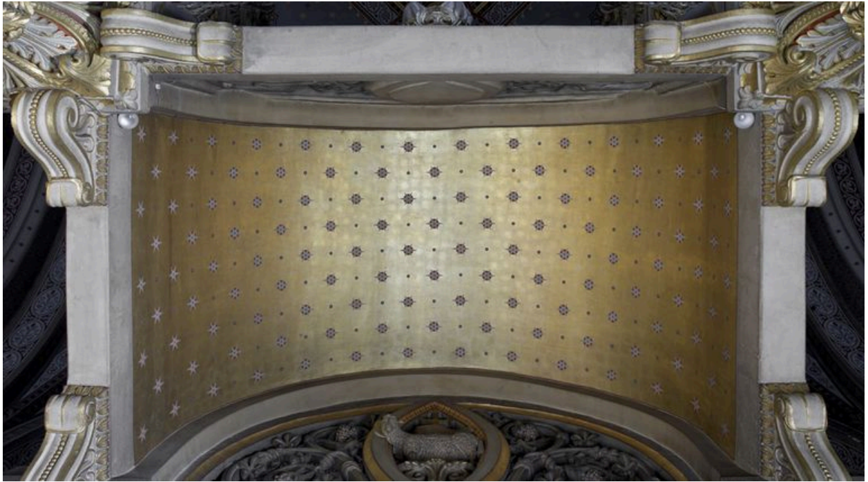
Détail de la voûte en face interne
