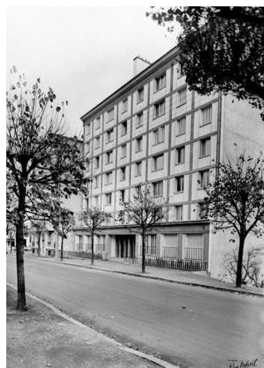
Vue de la façade principale de l'HLM Glangeaud Repro. Roger Choplain, Repro. Roland Maston, Autr. Raymond Delvert IVR83_20006300241X
