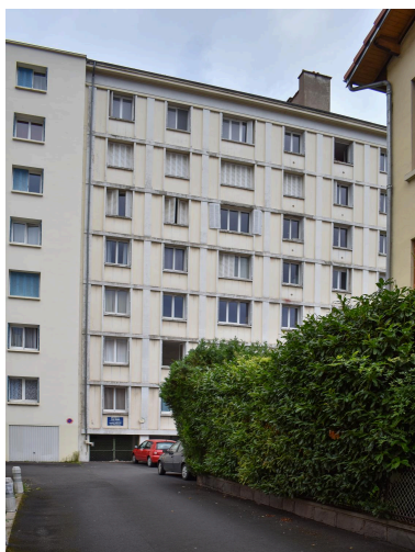
Elévation postérieure vue depuis le coeur d'îlot Phot. Félicie Fougère IVR84_20246301694NUCA
