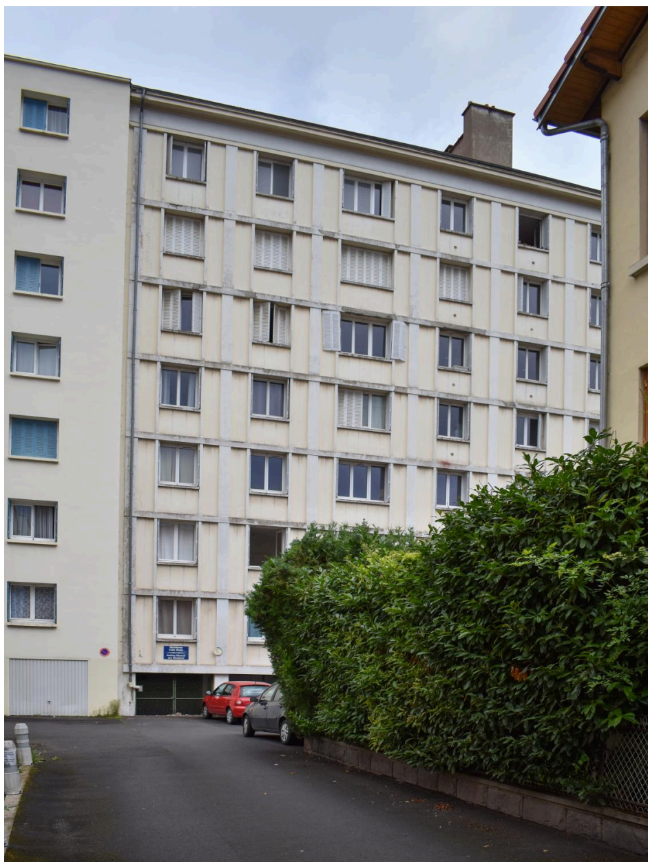
Elévation postérieure vue depuis le coeur d'îlot
