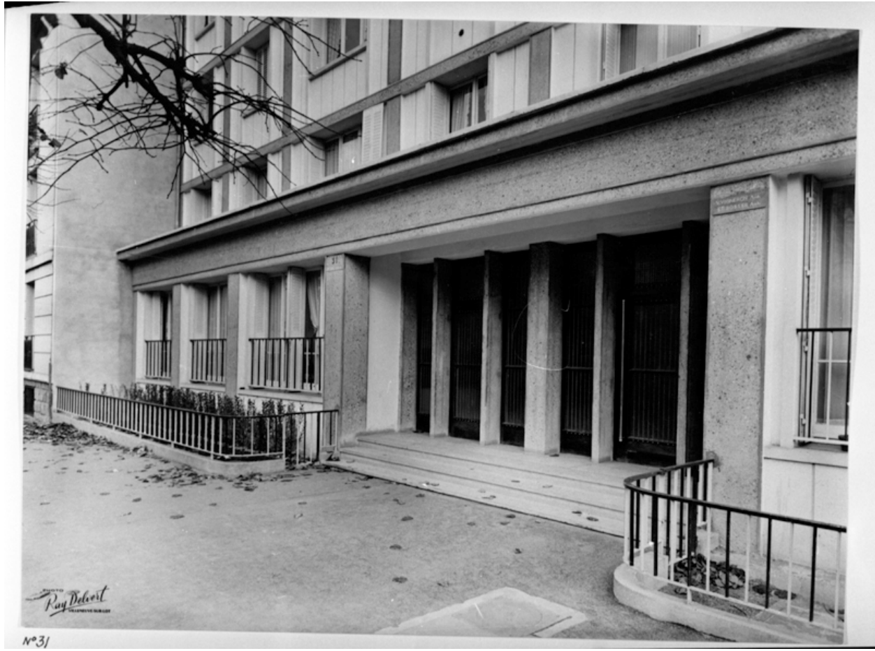
Détail de la porte d'entrée principale de l'HLM Glangeaud
