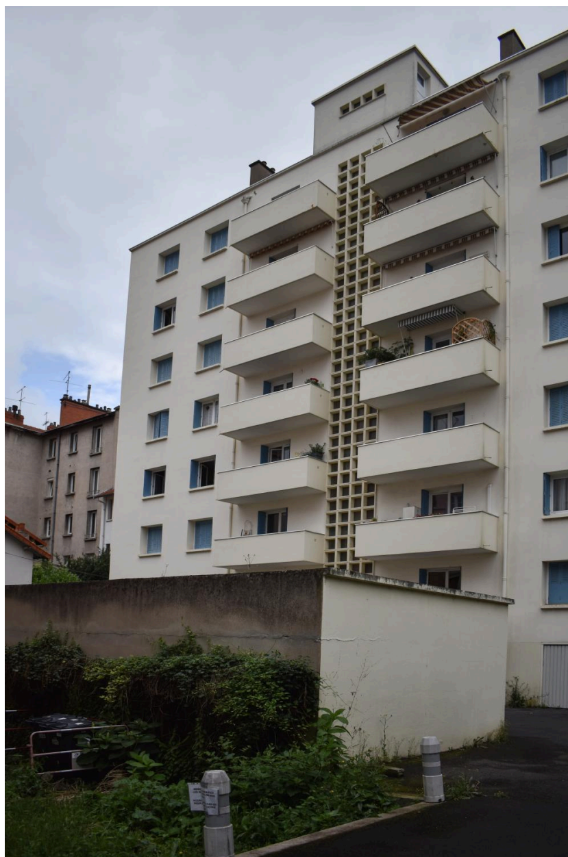
Elévation postérieure vue depuis le coeur d'îlot
