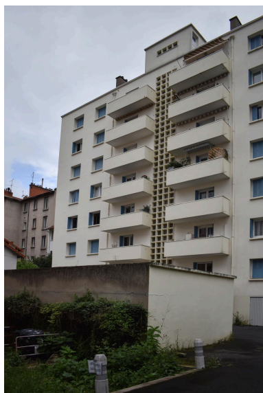
Elévation postérieure vue depuis le coeur d'îlot Phot. Félicie Fougère IVR84_20246301693NUCA
