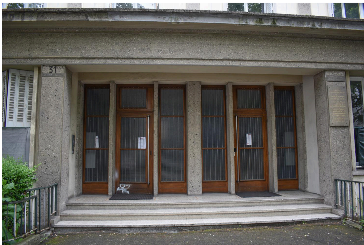
Portes d'entrée de l'immeuble sur le boulevard Cote-Blatin
