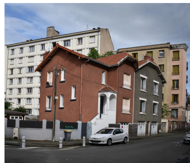
Au premier plan, les maisons rue Philippe-Glangeaud, à l'arrière-plan les immeubles du boulevard Cote-Blatin Phot. Félicie Fougère IVR84_20246301664NUCA
