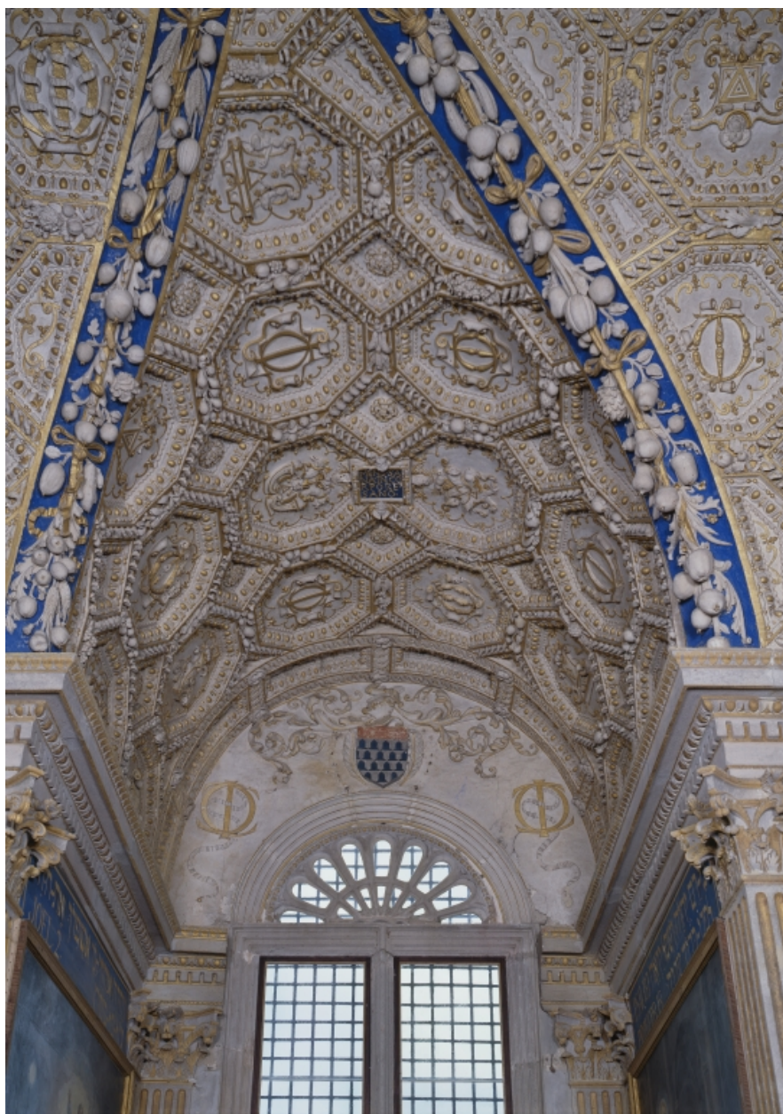
Vue générale du voûtain de l'oratoire.
