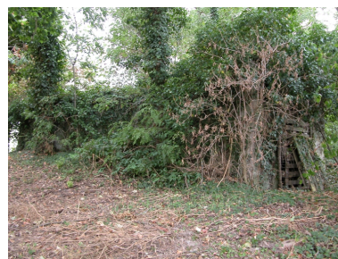
Vue de l'entrée de la glacière. Phot. Thierry Monnet IVR82_20134202961NUCA
