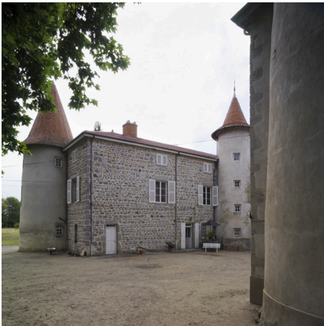
Vue d'ensemble de l'aile sud, depuis le nord-est.
