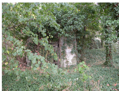
Vue de l'entrée de la glacière. Phot. Thierry Monnet IVR82_20134202962NUCA
