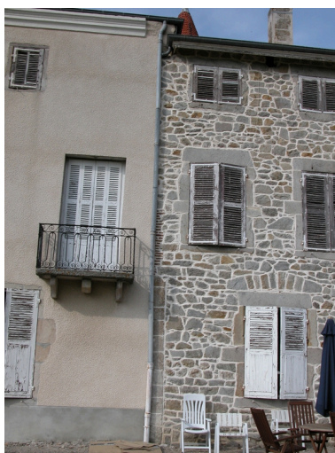
Détail du raccord entre corps central et ailé sud, élévation sud. Phot. Thierry Monnet IVR82_20134202958NUCA
