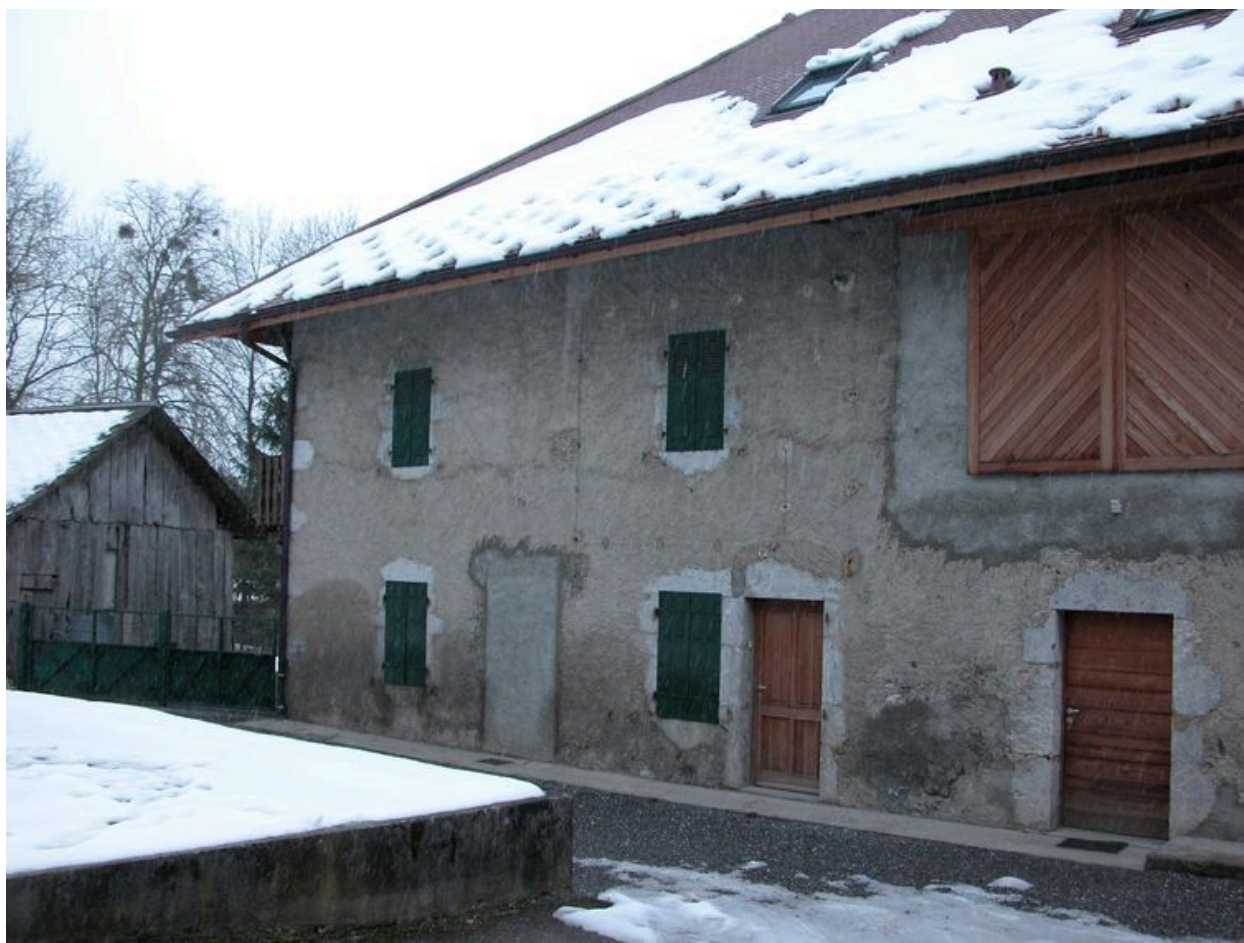
Vue de la façade nord-est avec encadrements de porte et fenêtre accolés.
