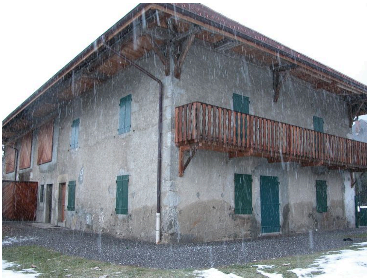
Vue du pignon sud avec balcon contemporain.
