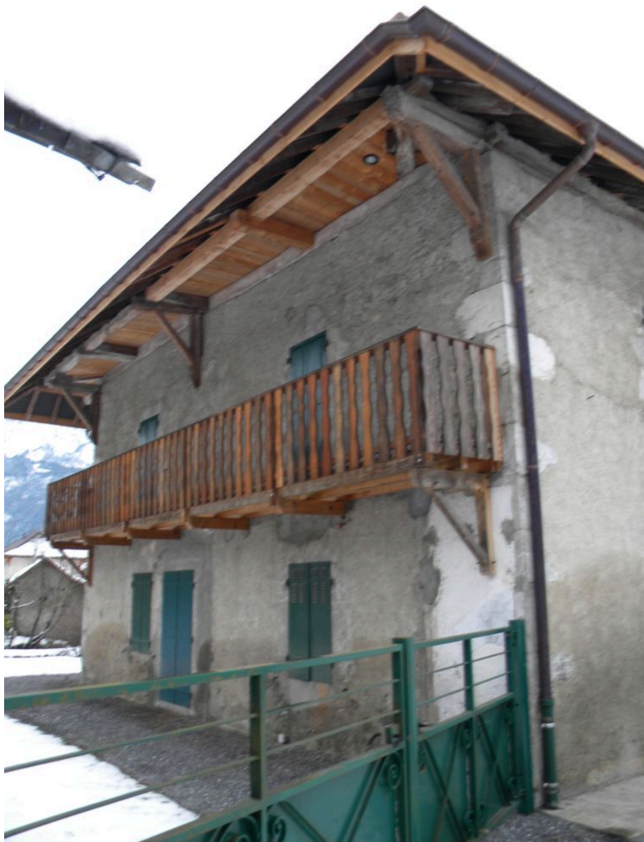
Vue du pignon sud avec balcon contemporain.
