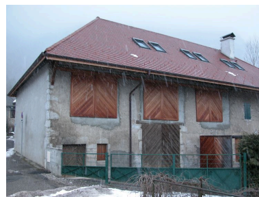
Vue de la façade sud-ouest avec ouvertures de fenil reprises en bardage. Phot. Jérôme Daviet IVR82_20107400922NUCA
