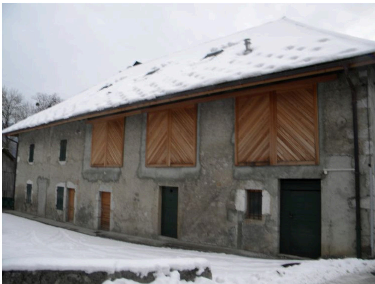
Vue intégrale de la façade nord-est.
