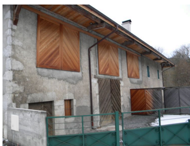
Vue de la façade sud- ouest avec ouvertures de fenil reprises en bardage. Phot. Jérôme Daviet IVR82_20107400923NUCA
