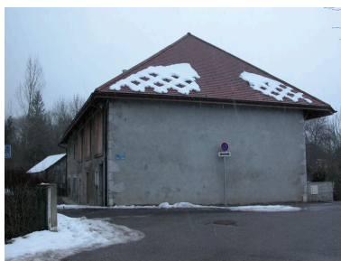
Vue du pignon nord. Phot. Jérôme Daviet IVR82_20107400926NUCA
