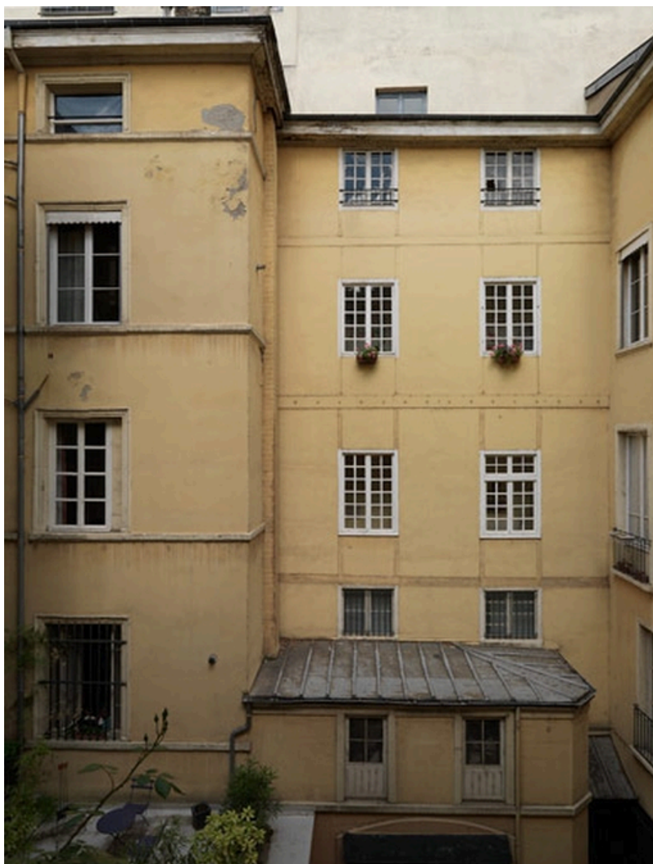
Vue générale de l'aile est depuis la cour secondaire (3 rue du Colonel-Chambonnet)
