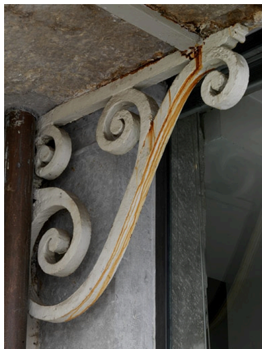
Console métallique XIXe siècle, cour, ailes est et ouest Phot. Eric Dessert IVR82_20106902328NUCA
