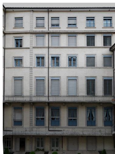
Vue de l'élévation est de la cour Phot. Eric Dessert IVR82_20106902319NUCA
