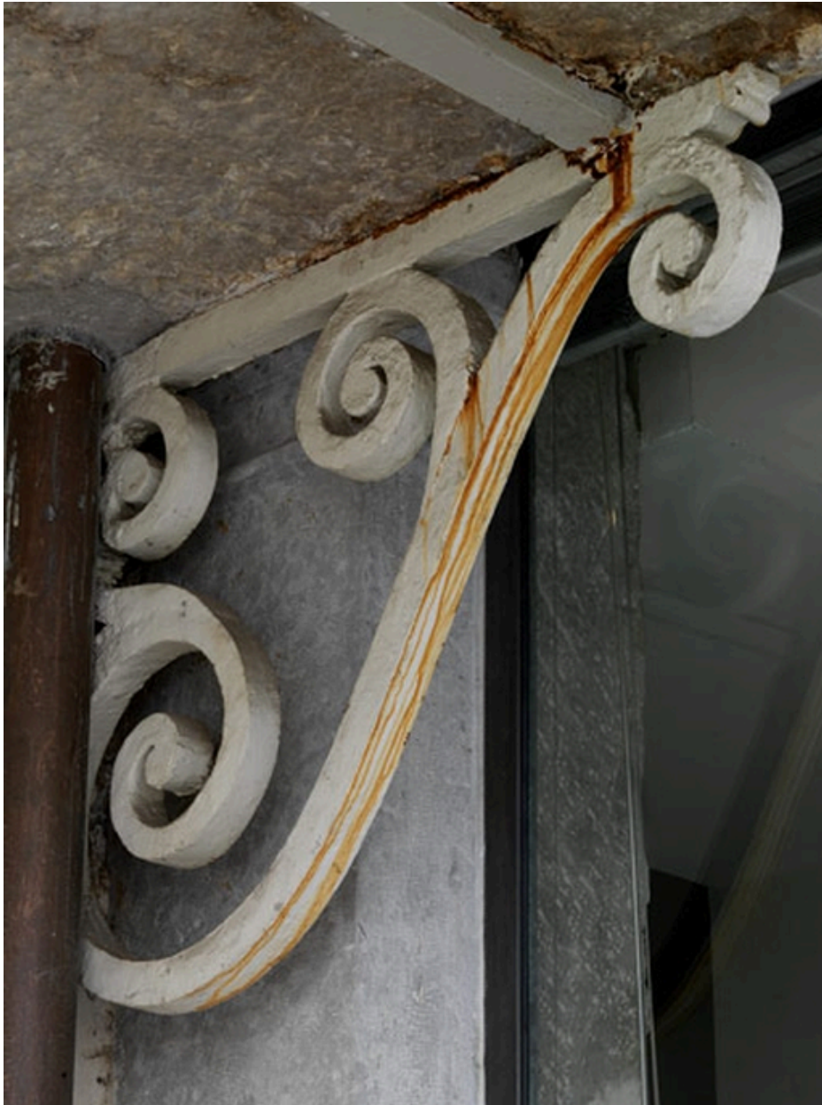
Console métallique XXe siècle, cour, ailes est et ouest
