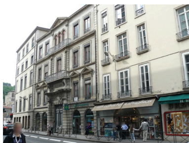
Elévation sur la rue du Colonel-Chambonnet
