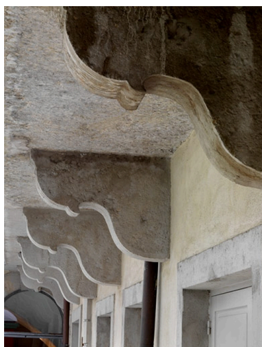
Consoles XVIIIe siècle, cour, ailes est, nord et ouest Phot. Eric Dessert IVR82_20106902326NUCA
