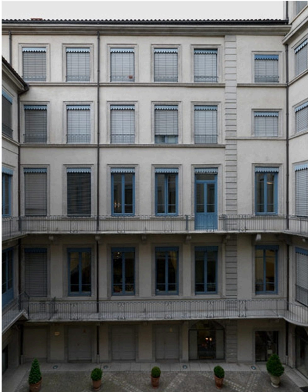
Vue de l'élévation ouest de la cour
