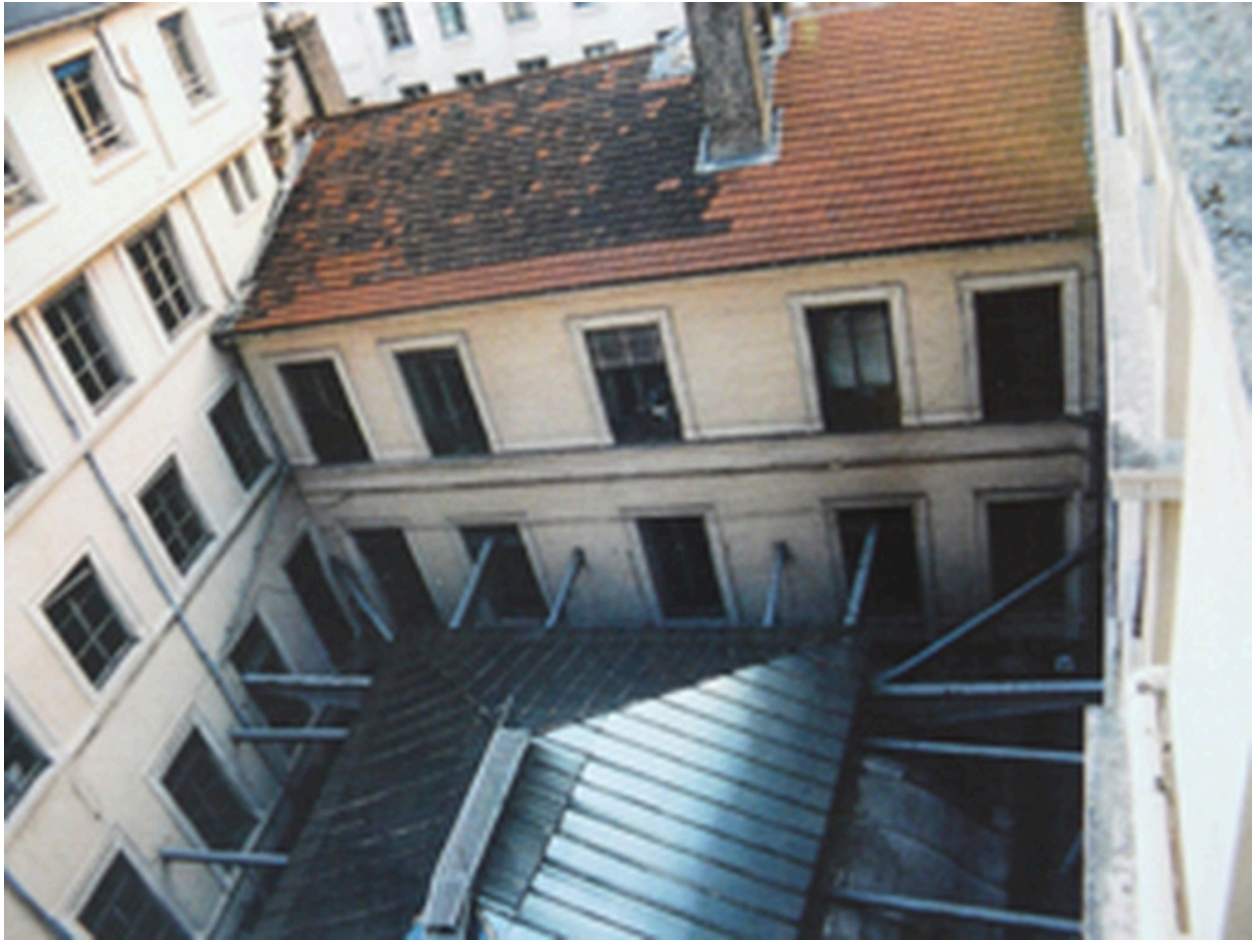
Vue de la couverture de la salle de bal depuis les étages supérieurs de l'hôtel
