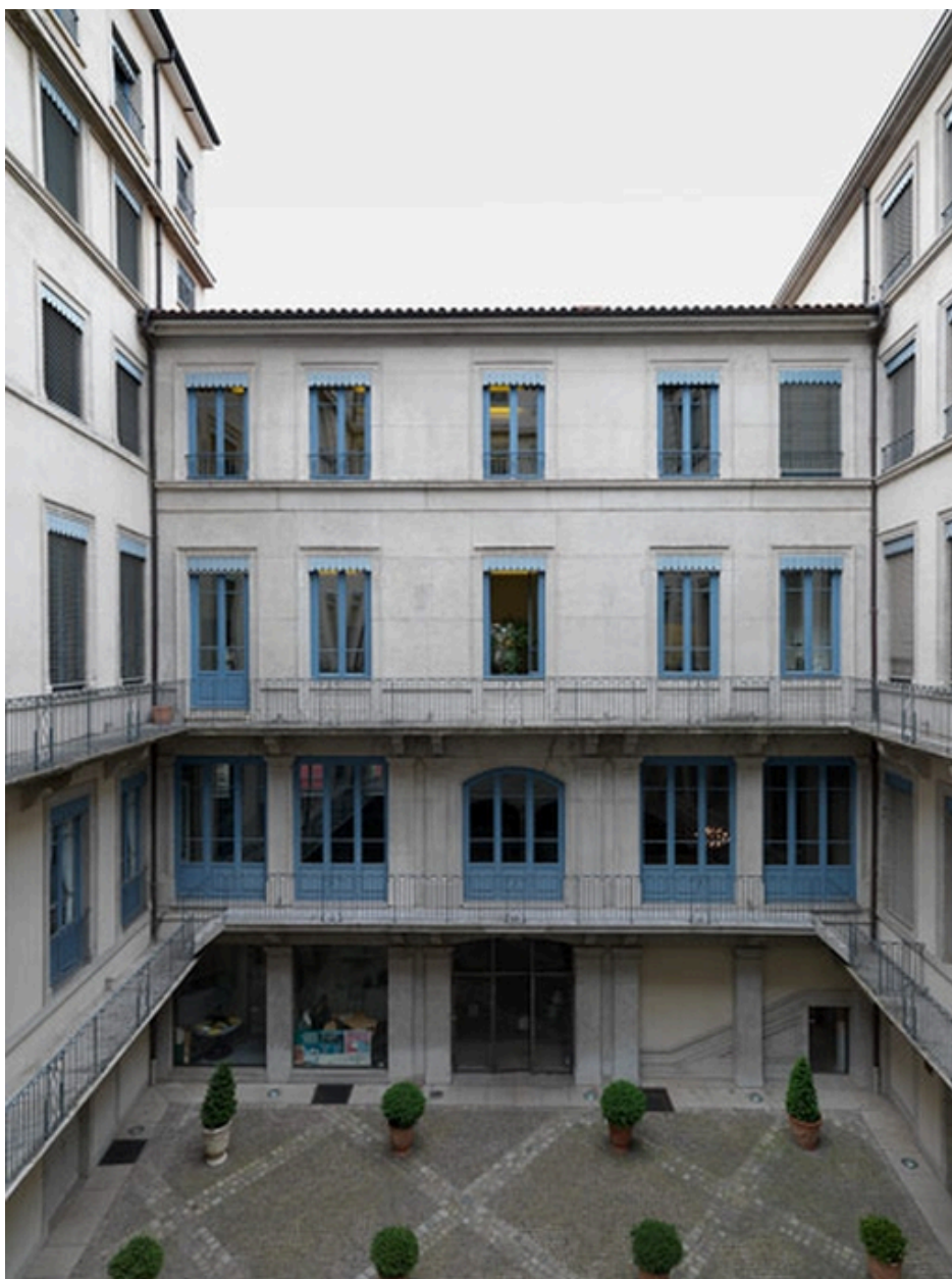
Vue de l'élévation sud de la cour
