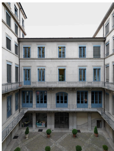
Vue de l'élévation sud de la cour Phot. Eric Dessert IVR82_20106902317NUCA
