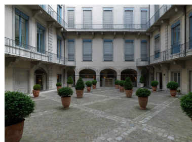
Vue générale de la cour (ailes nord, est et ouest) depuis le porche (aile sud)
