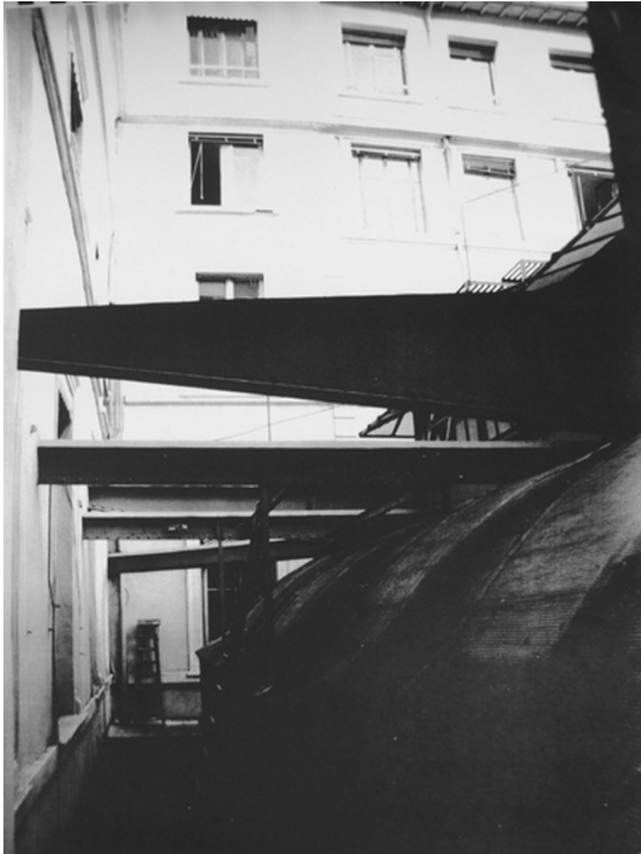
Tirants métalliques de l'ancienne salle de bal dans la cour intérieure
