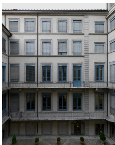
Vue de l'élévation ouest de la cour Phot. Eric Dessert IVR82_20106902318NUCA
