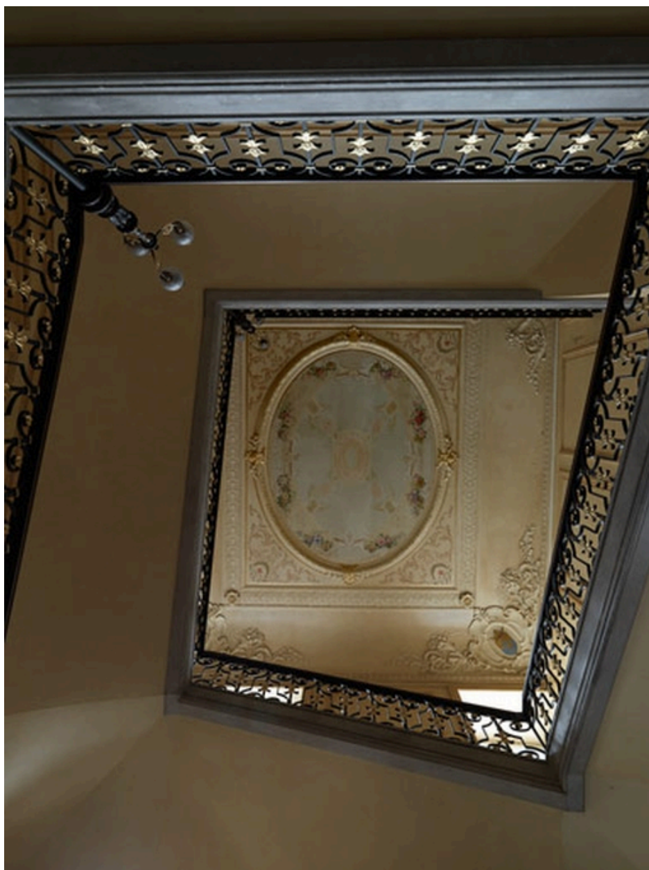
Escalier principal, aile sud, plafond
