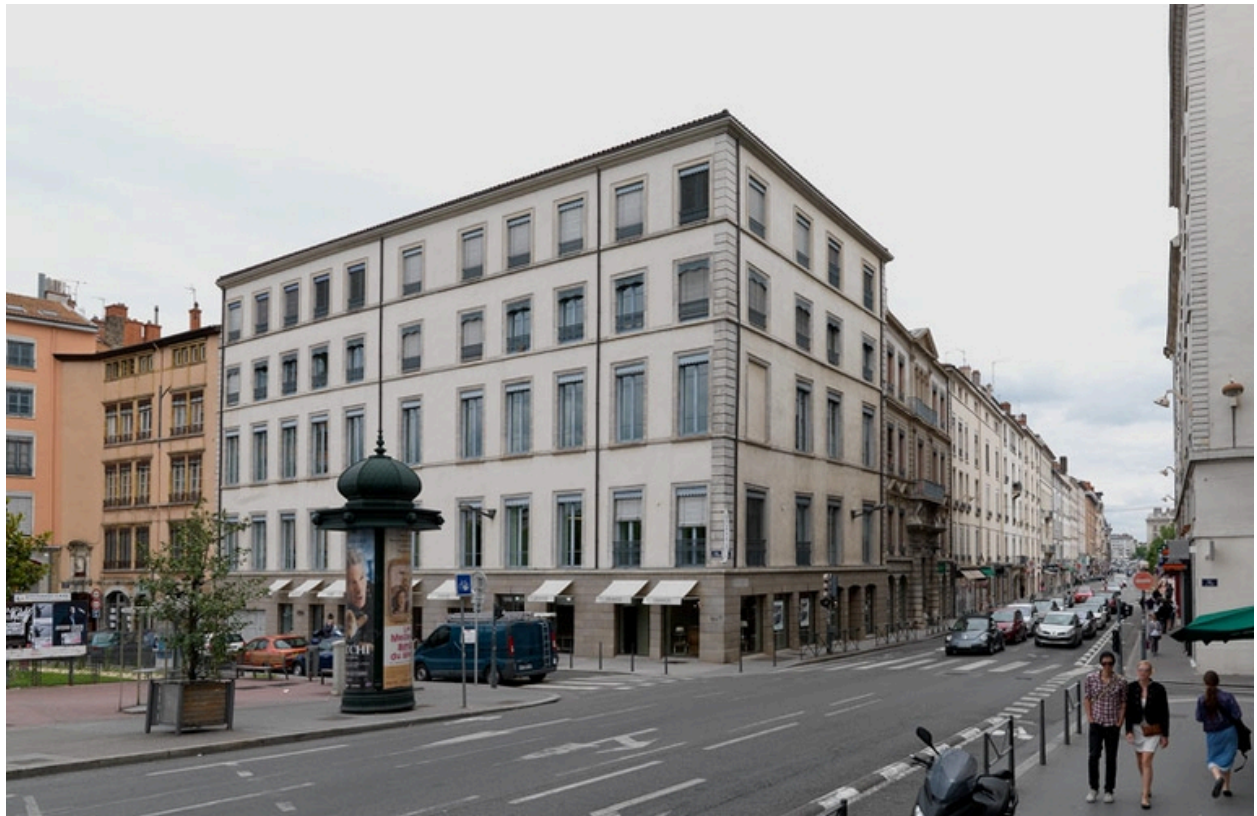
Vue de situation de l'élévation à l'angle de la place Antonin-Gourju et de la rue du Colonel-Chambonnet
