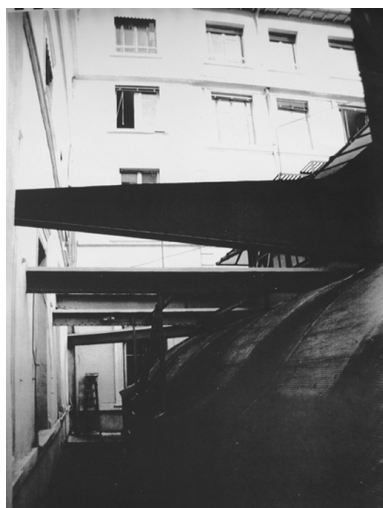
Tirants métalliques de l'ancienne salle de bal dans la cour intérieure Repro. Elodie Saget IVR82_20106903771NUCY
