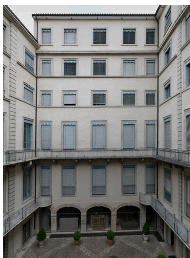
Vue de l'élévation nord de la cour Phot. Eric Dessert IVR82_20106902316NUCA
