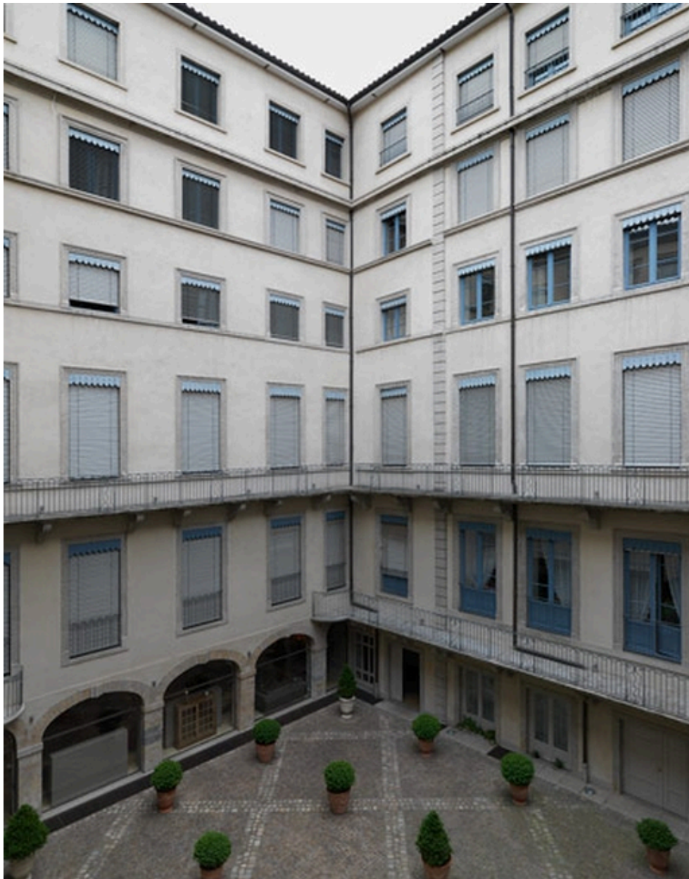
Vue de l'élévation à l'angle nord-est de la cour
