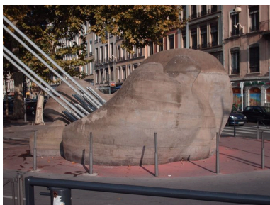
Forme sculpturale enveloppant le massif d'ancrage de la passerelle du Palais de Justice, Gabriel Gouttard Phot. Véronique Belle
