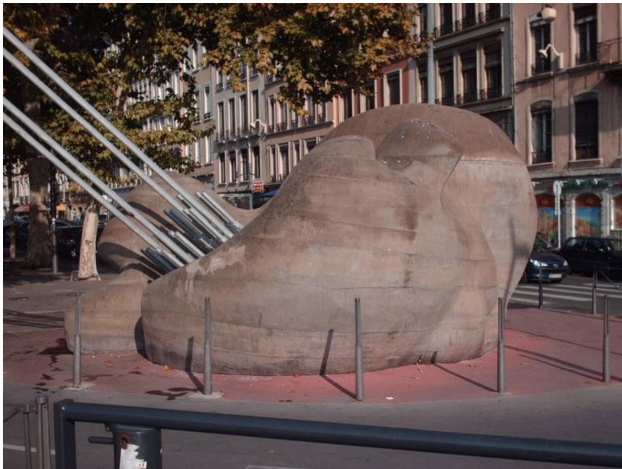
Forme sculpturale enveloppant le massif d'ancrage de la passerelle du Palais de Justice, Gabriel Gouttard
