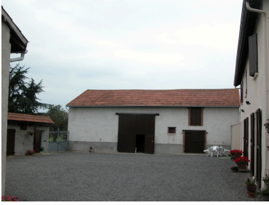
Vue générale. Phot. Thierry Monnet IVR82_20134204653NUCA
