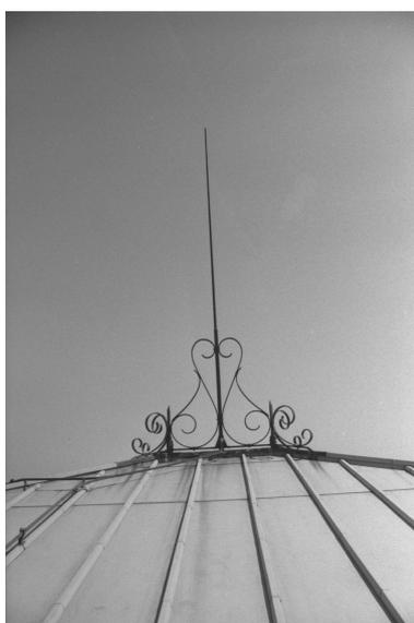
Paratonnerre en fer et fer forgé. Toit
