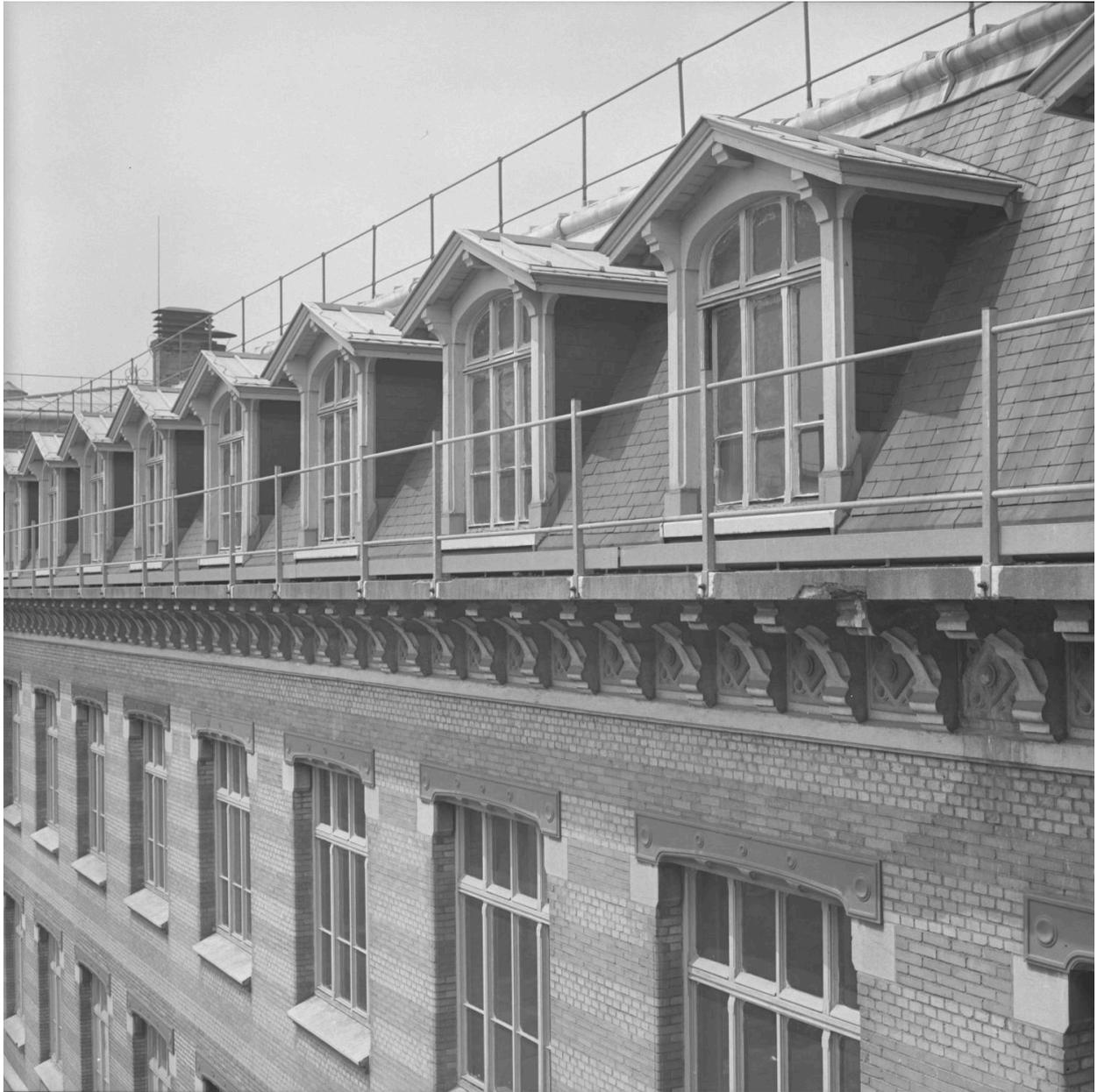
Bâtiment D, façade sud. Morceau de béton de la corniche perdu; graves fissures dans les consoles
