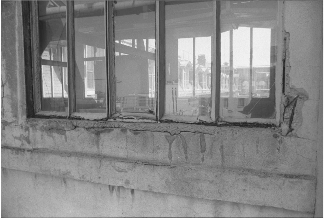
Cadres de fenêtres installés directement dans le béton, rouillés sur la face ouest de chaque pont. Pont de service entre le pavillon CD et FC
