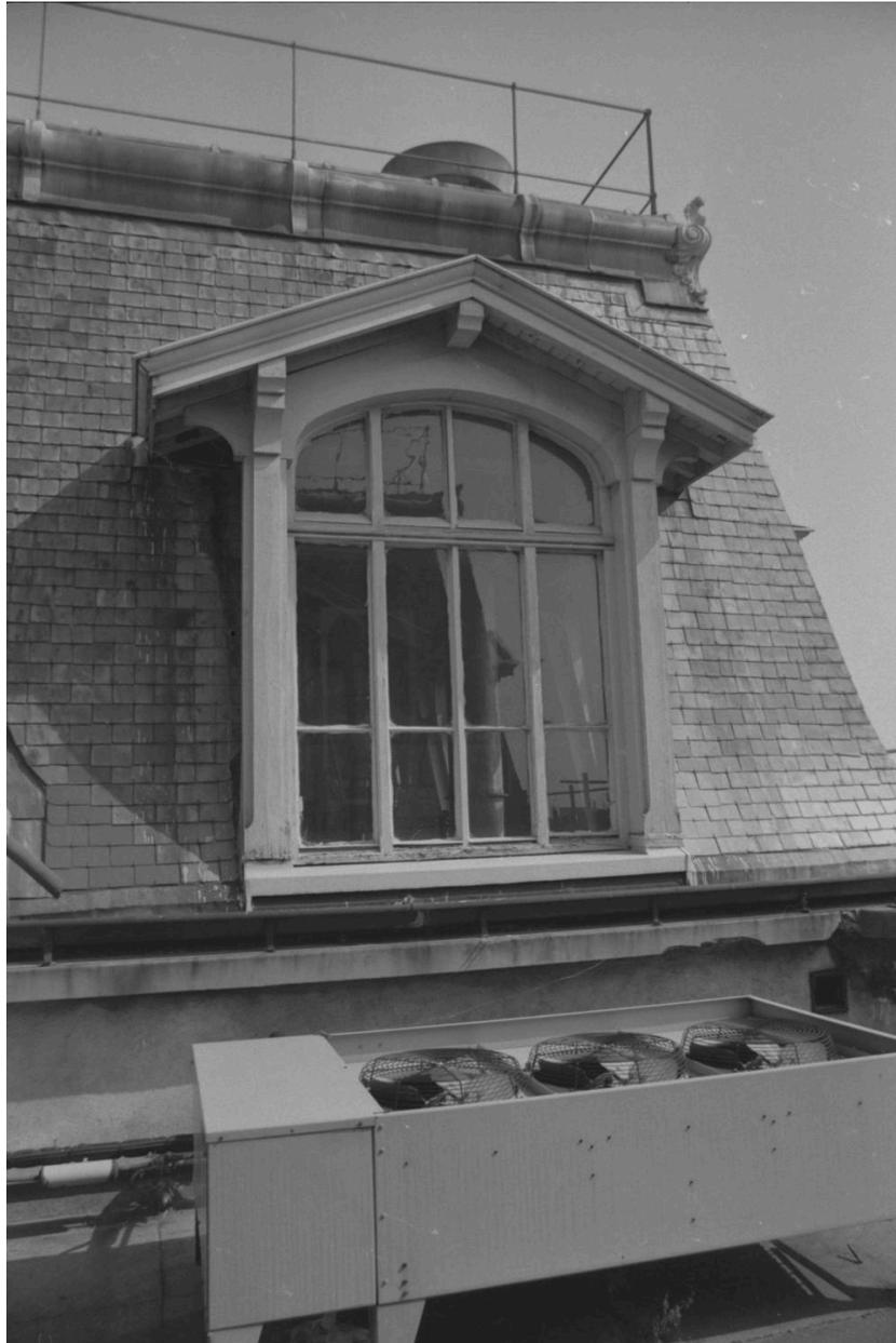
Lucarne en chêne. Toit à la Mansard recouvert d'ardoise. Chêneau en tôle. Garde-corps du terrasson en fer. Pavillon BD, toit sud, moitié est
