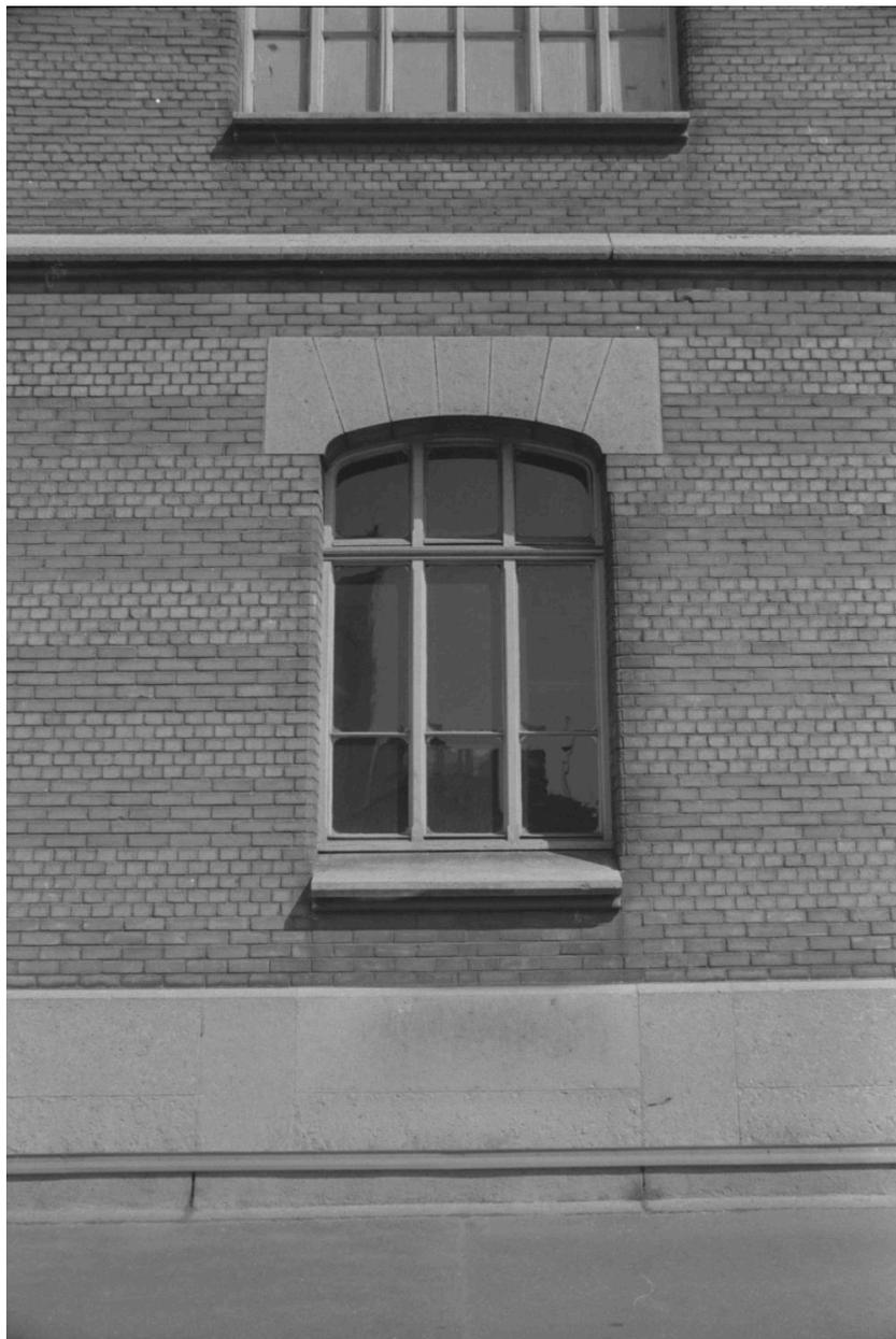
Fenêtre en chêne; châssis métallique. Pavillon FC; façade est, rez-de-chaussée
