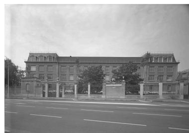
Façade nord du bâtiment d'exploitation. Partie centrale du toit reconstruit sans lucarnes après l'incendie (ni les lampes ni la grille d'entrée sont d'origine)
