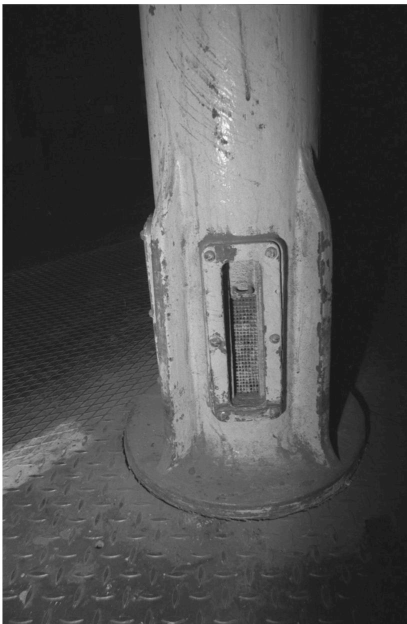
Socle de colonne en fonte. Prise d'air prévue comme gaine de chauffage. Pavillon BD, 2e étage
