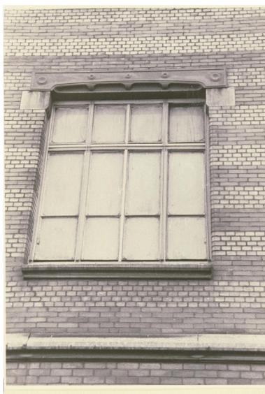
Fenêtre en chêne; châssis métallique. Linteaux en fonte de section creuse. Stores en bois. Appareillage en brique. Bâtiment B; façade est, 1er étage
