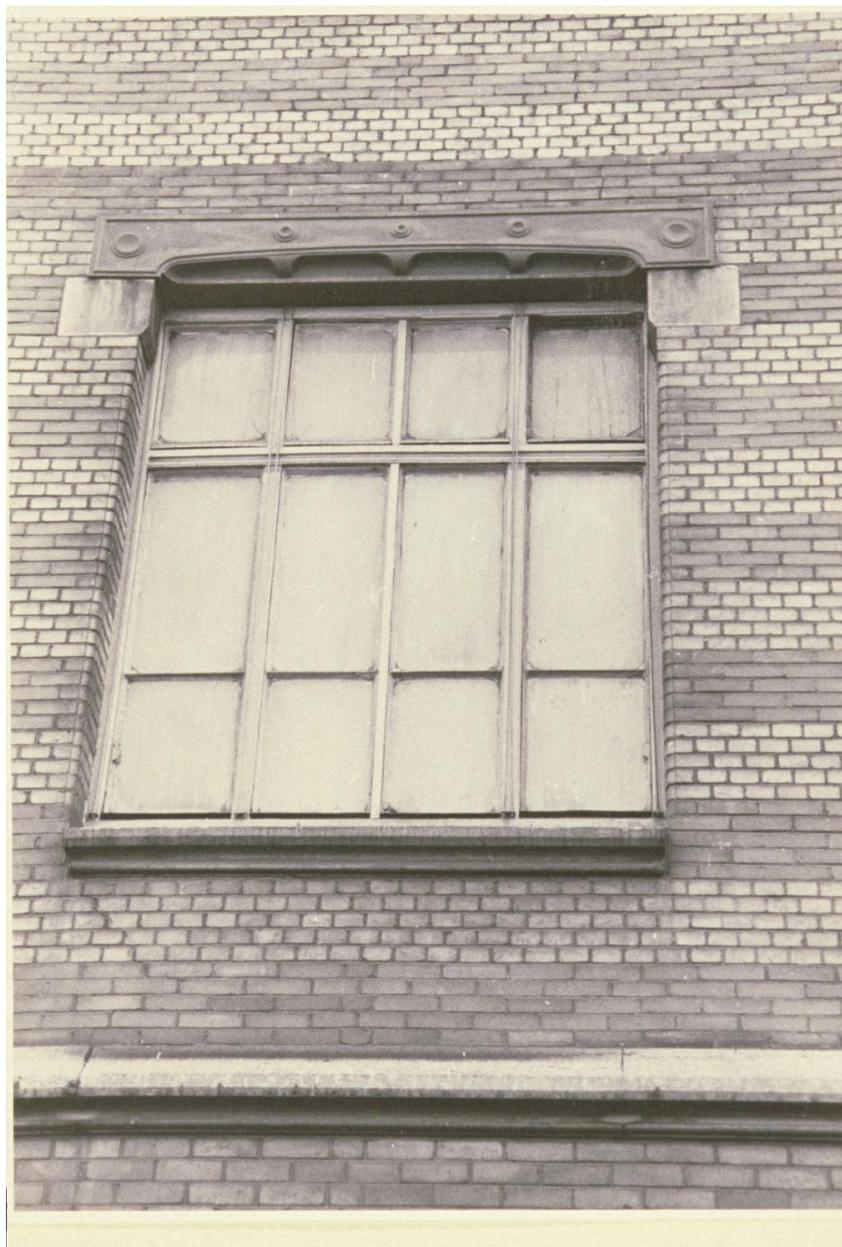
Fenêtre en chêne; châssis métallique. Linteaux en fonte de section creuse. Stores en bois. Appareillage en brique.
