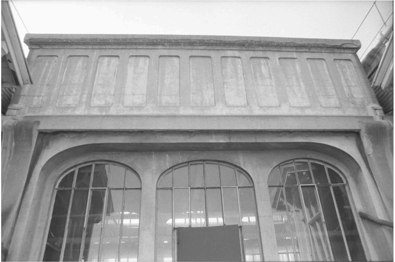
Ebranlement sévère du chéneau en béton. Pont de service entre les pavillons BD et EB, 3e étage, mur est
