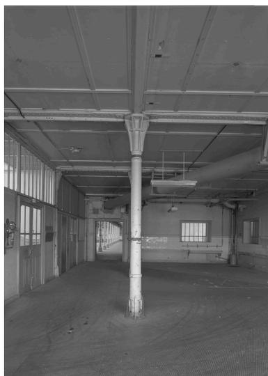
Pavillon AB. Atelier B en arrière plan. Les chapiteaux des colonnes en fonte supportent les cloisons
